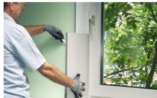
Speziell für die Innendämmung von Tür- und Fensterlaibungen wurde das Laibungs-VacuPad entwickelt. Es verfügt über einen schlanken Aufbau und lässt sich bequem zuschneiden.
