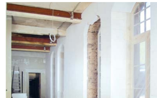
weber.therm MD 042 Dämmboards lassen sich optimal an die Raumgeometrie anpassen. Flankierende Bauteile wie z.B. Türen oder Unterzüge können exakt eingefasst werden.
