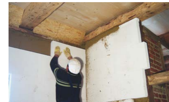
Bei der Innendämmung von Fachwerkhäusern bieten sich mineralische Dämmplatten an. Kombiniert mit einem Kalk-Innenputz sorgen sie für einen optimalen Feuchtehaushalt und ein dauerhaft gesundes Wohnklima.
