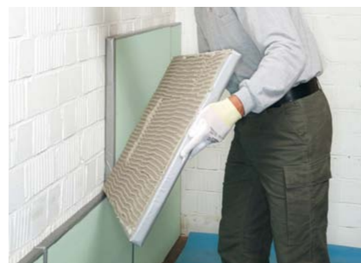
Einfach und schnell zu verarbeiten: Auch das weber.therm Vakuum Innendämmsystem zeichnet sich durch einfache Handhabung aus.
