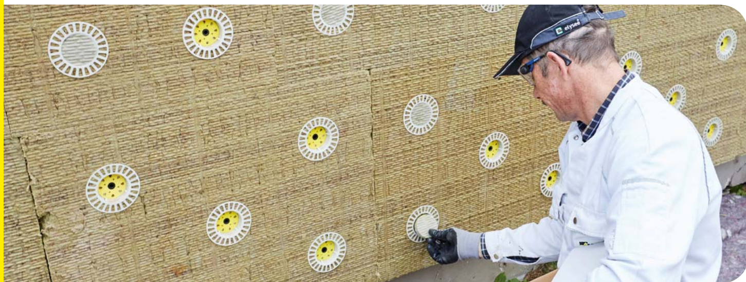
Dübelschema a | (4 Dübel pro m 2 )
