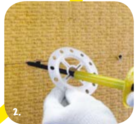
Bilder 1-4: Mineralwoll-Dämmplatte, oberflächenbündige Montage mit Zusatzteller, 90 mm
