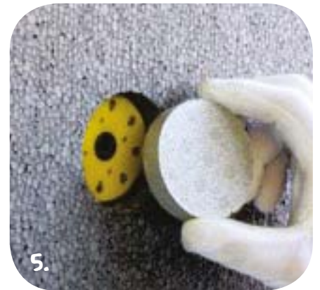
Mit Rondelle abdecken. Ergibt homogene und störungsfreie Oberflächen.
