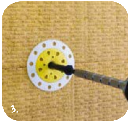
Mit weber.therm SRD Verstellerschaft Sechskant SW 10x160 bündig zur Oberfläche einschrauben.
