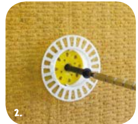
Bilder 1-3: Mineralwoll-Dämmplatte, vertiefte Montage mit Zusatzteller, 112 mm
