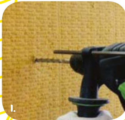
Bilder 1-4: Mineralwoll-Dämmplatte, oberflächenbündige Montage mit Zusatzteller, 90 mm
