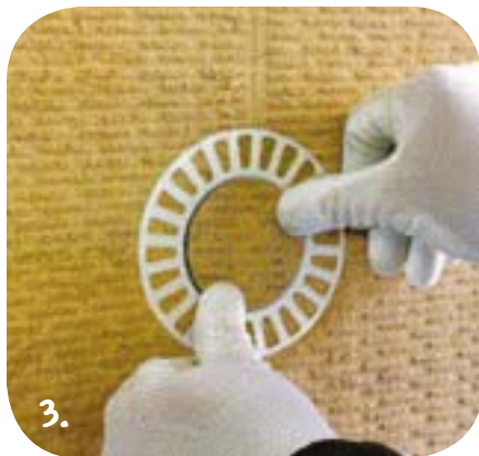
Mit dem weber.therm Dübelteller VT112 wird der Dübel während der Verschraubung im Dämmstoff versenkt und anschließend mit einer Mineralwollrondelle abgedeckt.
