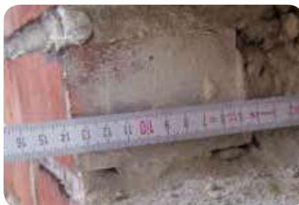
**5. Zweischaliges Mauerwerk I ( $d = 90 \text{ bis } < 115 \text{ mm}$ )**
