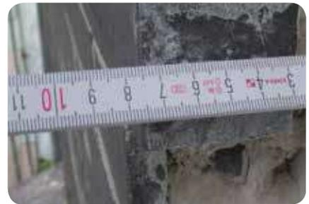
**3. Sparverblender I ( $d = 55 \text{ bis } < 90 \text{ mm}$ )**
