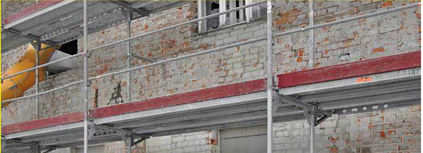
**Sicherung einer keramischen Bekleidung oder eines zweischaligen Mauerwerks an Fassaden**
