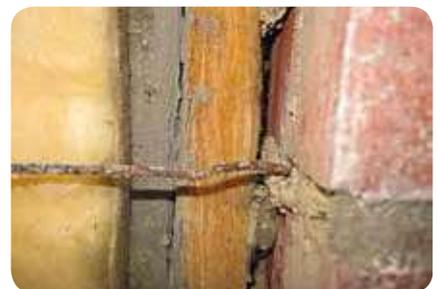
**6. Zweischaliges Mauerwerk II ( $d \geq 115 \text{ mm}$ )**
