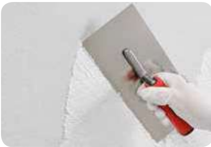
1. Oberputz mit einem Glätter/Traufel aufziehen.
