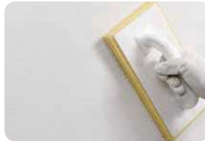
5. Zum Abreiben oder Abfilzen des Unterputzes ein Schwammbrett verwenden.
