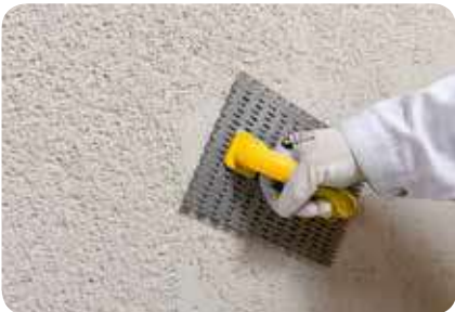
2. weber.top Edelkratzputze werden mit einem Kratzbrett gekratzt.
