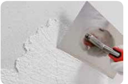
3. Zum Auftragen oder Verziehen von weber.star Edelputzen wird ein Glätter/Traufel empfohlen.
