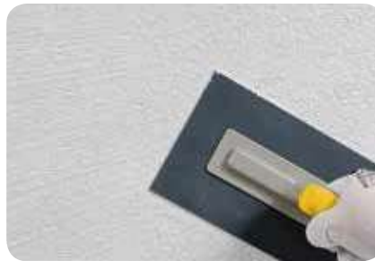
2. Oberputz mit einem Kunststoffglätter strukturieren.
