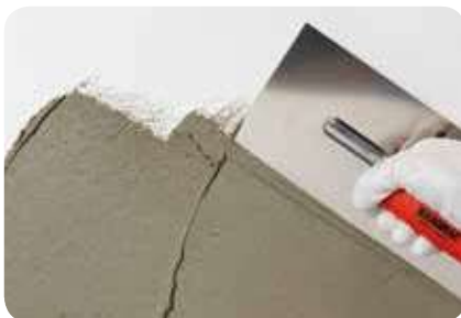
1. Zum Auftragen und Planziehen wird ein Glätter/Traufel empfohlen.
