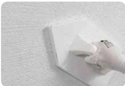
4. weber.star Edelputze werden mit einem Kunststoffglätter oder Styropor-Reibebrett gerieben bzw. geschleibt.
