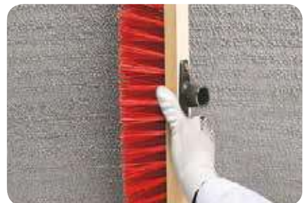
3. Für die dickschichtigen Oberputze (z.B. Kratzputz) wird der Armierungsmörtel nach dem Anziehen mit einem Straßenbesen aufgeraut, die übrigen Oberputze rau abgerieben.
