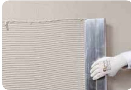
2. Zum Zuziehen eine Zahnkartätsche verwenden.
