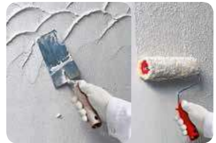
3. Freistrukturierbare Oberputze können mit verschiedenen Werkzeugen strukturiert werden, z.B. mit Kelle oder Strukturwalze .
