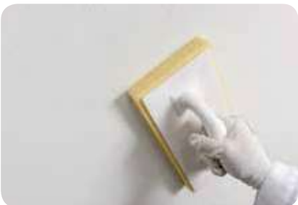
5. Filzputze, z.B. weber.star 295 , werden mit einem Schwammbrett gefilzt.
