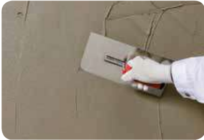
1. Zum Auftragen einen Glätter/Traufel einsetzen.
