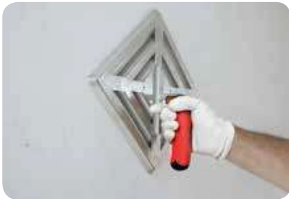
4. Zum Egalisieren wird ein Rabbospeed empfohlen.
