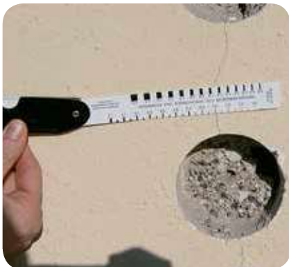
1. Riss aufgrund zu hoher Druckfestigkeit des Putzes
