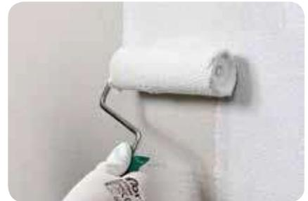
3. Nach Applikation des Oberputzes (dünn-schichtig mineralisch oder pastös) erfolgt immer ein mind. 2-facher Anstrich mit **weber.ton 412** oder **420**, um eine einheitliche Farbgebung sicherzustellen. Besonders intensive und dunkle Farbtöne können mit **weber.ton Xtreme Fassadenfarbe Intensiv Color** gestrichen werden.
