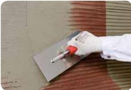
1. Nach einer Standzeit der ersten Armierungsschicht von 7 Tagen erfolgt eine zweite Armierungsschicht. Diese ist notwendig, um die hygrothermischen Beanspruchungen im System aufzunehmen. Aufgrund der immer größer werdenden Dämmstoffdicken und dem zunehmenden Einsatz von elastifizierten Dämmstoffplatten werden die Spannungen, welche auf den Putz wirken, immer höher und das Ausführungsrisiko steigt.
