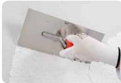
2. Die freie Fassadenrandverschiebung der Putze auf WDVS steigt. Somit ist der sichere Aufbau in Verbindung mit dunklen Farben mit einer zweifachen Armierungslage unabdingbar. Bitte den Anwendungstipp „... solider Anschluss an ein Fenster- oder Türelement...“ beachten.
