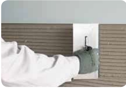
16. Bei Kleberauftrag auf der Wand gewährleistet die Spitzzahnkelle Nr. 2 eine optimale Kleberverteilung auf der gesamten Fläche.
