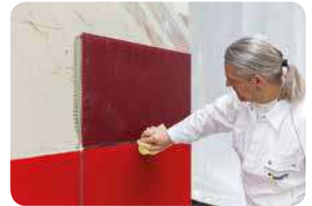
21. Direkt nach der Verlegung sind Fugen und Gläser von Kleberesten zu reinigen.
