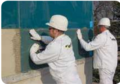
19. Mit leichtem Druck lassen sich die Elemente in ihre endgültige Position bringen ...
