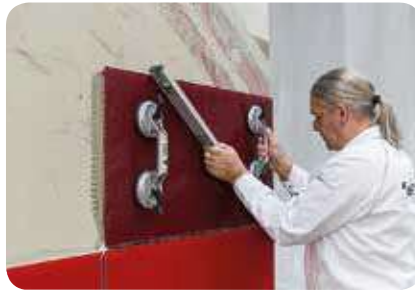
20. ... und planeben exakt ausrichten.
