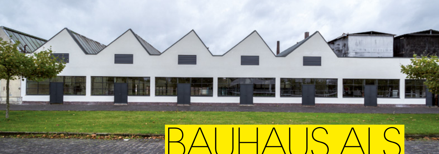
©Mies van der Rohe Business Park
