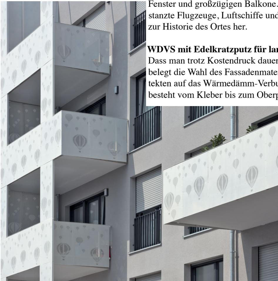
und basiert auf Mineralwoll-Dämmplatten mit einem Wärmeleitwert von 0,035 W/mK. Dieser homogene diffusionsoffene Systemaufbau ermöglicht einen optimalen Feuchtigkeitshaushalt und ermöglicht dank Baustoffklasse A1 maximalen Brandschutz ohne Zusatzmaßnahmen.
