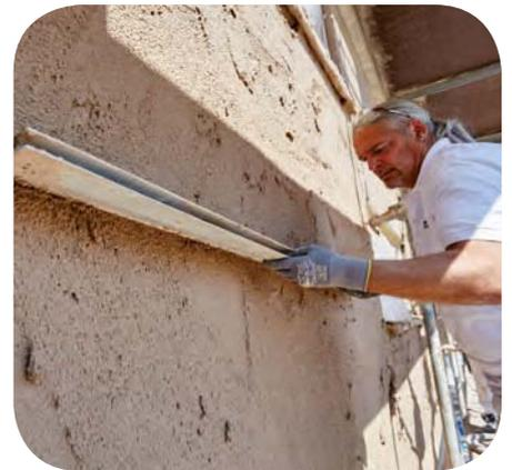
Ob als Fassaden-Grundputz oder auf Innenwänden, Unterputze erfüllen wichtige Funktionen im Wandaufbau. Sie schützen dauerhaft vor Feuchtigkeit und gleichen Spannungen aus. Sie bilden einen ebenen und sicheren Haftgrund für hochwertige Oberputze oder erscheinen als Einlagenputz mit edel gefalzter Oberfläche. Entscheidend für ein erstklassiges Ergebnis sind in jedem Fall hervorragende, auf den Untergrund abgestimmte Verarbeitungseigenschaften.
