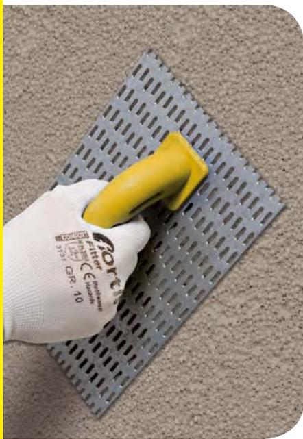
Profis wünschen sich einen Unterputz, der nach dem Auftragen früh zu bearbeiten ist, aber nicht zu schnell abbindet. Diese Voraussetzungen erfüllen die **weber.dur SLK**-Putze. Ihr Abbindeverhalten ist so optimiert, dass ohne lange Wartezeiten mit der Endbearbeitung begonnen werden kann. Gleichzeitig bieten sie ein verlängertes Zeitfenster für das Rabottieren oder Glätten der Oberfläche.
