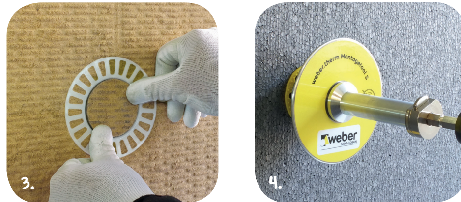
Mit dem weber.therm Dübelteller VT112 wird der Dübel während der Verschraubung im Dämmstoff versenkt und anschließend mit einer Mineralwollrondelle abgedeckt. Bohrloch erstellen, Dübel einstecken, bis er auf dem Dämmstoff aufliegt. Mit dem weber.therm SRD Montagetool S verschrauben und versenken.
