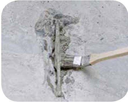
1. 2-facher Auftrag des Korrosionsschutzes, **weber.rep KB duo**
