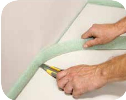
1. Die Randdämmstreifen werden vor Beginn der Abdichtungsarbeiten flächenbündig abgeschnitten.
