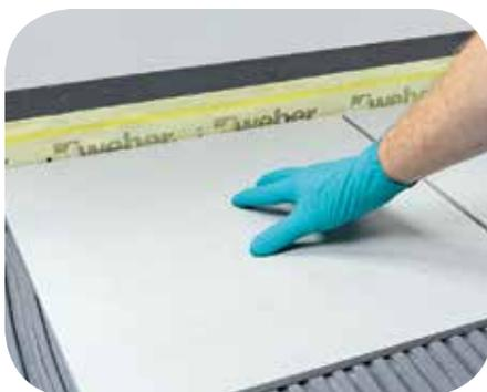
6. Abhängig von Größe und Rückseite des Verlegegutes kann die Verlegung auch im kombinierten Verfahren erfolgen.
