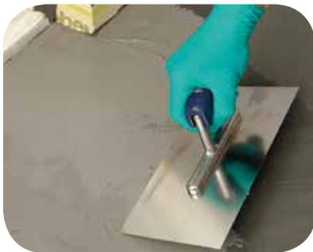
4. Im Anschluss wird **weber.xerm 844** in Form einer Kratzspachtelung aufgetragen.
