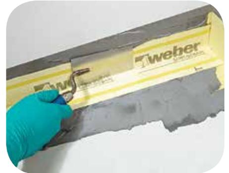
3. Die Dichtbandkomponenten **weber.tec 828** werden im Wandanschlussbereich mit **weber.xerm 844** eingeklebt und an den Randzonen überarbeitet.
