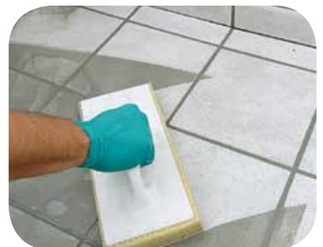
8. Nach Aushärtung der Abdicht- und Verlegesicht wird der neue Belag z. B. mit **weber.fug 877** verfugt.
