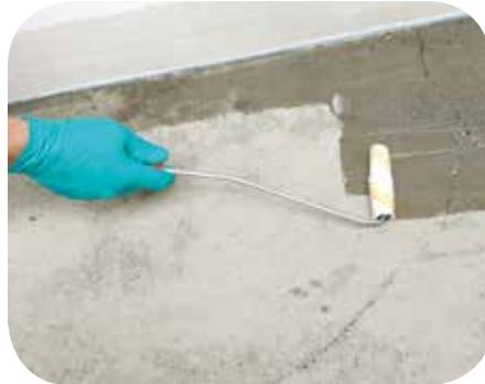
2. Untergrund vor der Verlegung auf Tragfähigkeit überprüfen, haftungsmindernde Bestandteile entfernen. Den sauberen Untergrund mit **weber.prim 801** grundieren.
