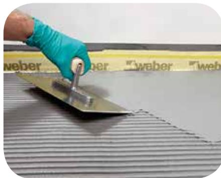
5a. Gemäß ZDB-Merkblatt ist die Abdichtung im Verbund (AiV) zweilagig aufzutragen. Die Gesamttrockenschichtdicke einer vollflächigen Kratzspachtelung beträgt mind. 2 mm.
