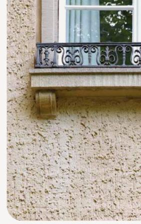
Ob Kratz-, Filz-, Schleppoder Steinputz – die Vielfalt an Putzoberflächen ist unbegrenzt. Mineralische Putze sind ein Material, mit dem sich unterschiedlichste Fassaden erzeugen lassen, von grob bis fein, von glatt bis rau.
