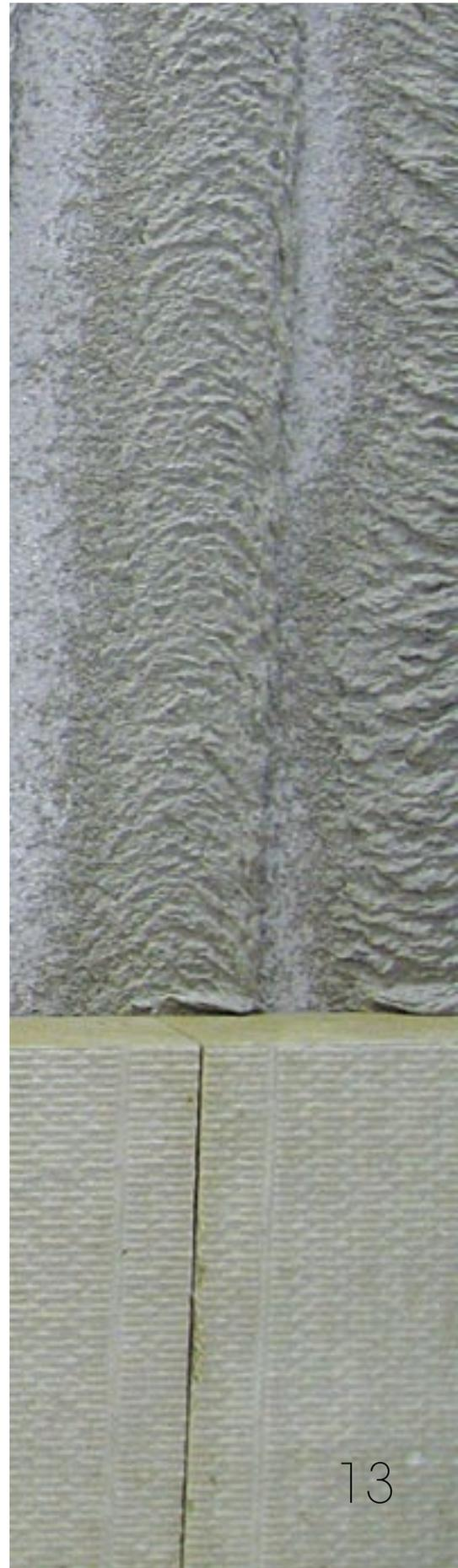
kann den Heizenergiebedarf eines Altbaus auf das Passivhaus-Niveau von unter 15 kWh/(m<sup>2</sup>a) senken. Tür- und Fensterlaibungen bleiben schlank und der oft bemängelte Schießscharteneffekt wird reduziert. Resol-Hartschaum bietet einen guten Brandschutz der Baustoffklasse B1 und kommt ohne zusätzliche Brandriegel aus, da das Material glutbeständig ist und nicht abtropft.
