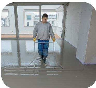
In bester Stuttgarter Wohnlage entstanden ab 2012 rund 70 hochwertige Wohneinheiten mit Parkett und Fußbodenheizung. Den Auftrag für den kompletten Fußbodenbau – Estrich und Parkett- erhielt die ADE Fußbodenbau GmbH. Ausgeschrieben war ursprünglich ein Zementestrich, die Boden-Profis entschieden sich jedoch für den calciumsulfatgebundenen Fließestrich **weber.floor 4491 turbo** von Saint-Gobain Weber.
