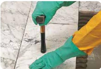
3. Großformatige Platten werden mit Verlegehilfen eingelegt und wenn nötig auf die erforderliche Belagshöhe eingeklopft.
