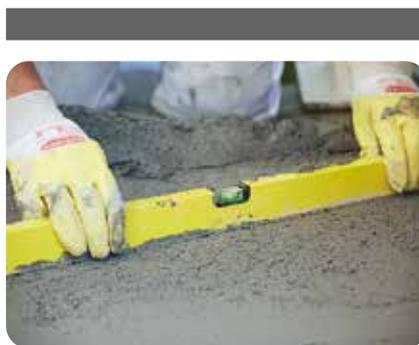
3. Der Estrich wird in die frisch aufgetragene Haftbrücke aufgebracht und im gewünschten Gefälle, z.B. über Estrichlehren, ausgezogen. Estrichlehre entnehmen und Flächen schließen.
