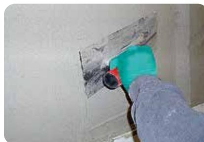
1. Mit einer Glättkelle eine vollflächige Kontaktschicht aus weber.plan 818 auf dem Untergrund erstellen.
