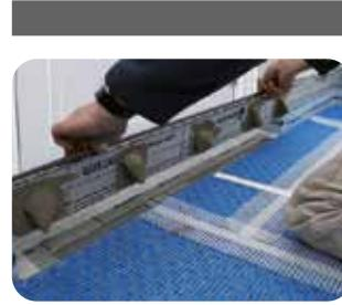
**8.** Die Drainrinne Watec® Drain RD auf den Klebemörtelpunkten z.B. aus **weber.xerm 859 F**, aufsetzen und mit Gefälle nach vorn ausrichten\*).
