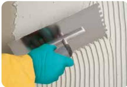
1. Auf den vorbereiteten Untergrund wird mit einem Glätter der Flex-Leichtfliesenkleber **weber.xerm 854/861** aufgetragen und anschließend mit einer Zahnkelle gleichmäßig abgekämmt.
