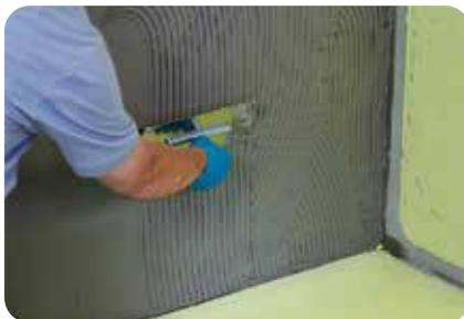
1. Zur Belagsverlegung wird zunächst eine Kontaktschicht aus **weber.xerm 859 F** vorgelegt. Sofort danach wird mit einem Kammspachtel in einem Winkel von 45–60° ein gleichmäßiges Klebebett aufgezogen.
