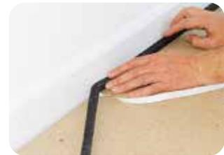
**4.** Um Schallbrücken und Spannungsrisse zu verhindern, wird zu angrenzenden Bauteilen (Wandanschlüsse, Rohrdurchführungen usw.) ein Randdämmstreifen eingebaut.
