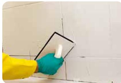
1. Nach dem Aushärten des Fliesenklebers kann der fertige Belag mit dem wasser- und schmutzabweisenden Longlife-Premium Fugenmörtel **weber.fug 875 BlueComfort** verfugt werden. Dieser Fugenmörtel zeichnet sich durch eine hohe Sanitärreinigerbeständigkeit aus.
