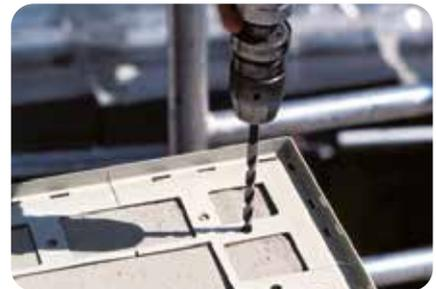
**3.** Für perfekte Fliesenabschlüsse können gegebenenfalls an den Stirnseiten des Estrichs geeignete Fliesen-Abschlussprofile eingebaut werden (verkleben und verdübeln). Diese werden später beim Auftrag mit der Verbundabdichtung eingebettet.
