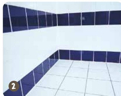
Anschluss- und Bewegungsfugen sind mit **weber.fug 880** oder **weber.fug 881** elastisch zu verfugen. Bei Natursteinbelägen ist **weber.fug 883** einzusetzen. Zur Haftverbesserung ist je nach Saugfähigkeit **weber.fug 884/885** zu verwenden.
