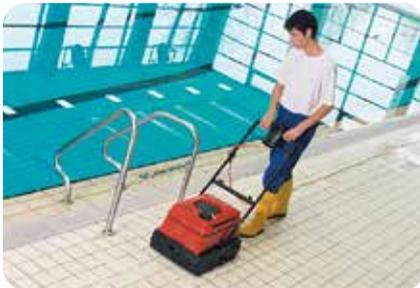
Bei einem normalen Fliesenbelag erfolgt die erste gründliche Reinigung der Beckenoberfläche nachdem die Fugen ausreichend erhärtet sind. Hierbei werden Rückstände von der Verfugung und der normalen Baustellenverschmutzung entfernen, damit kein Nährboden für eine spätere Verkeimung zurück bleibt. Ansonsten entsteht erfahrungsgemäß ein Befall durch Mikroorganismen, wie z.B. Schimmelpilze. Diese Reinigung erfolgt mit einer Chlorbleichlauge oder entsprechend geeigneten Reinigern auf dieser Basis.
