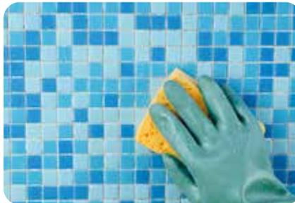
Wird in einem Schwimmbecken Glasmosaik, das in der Regel eine vorderseitige Papierverklebung hat, verlegt, erfolgt die erste Reinigung der Flächen bereits vor dem Verfugen. Dazu wird der Belag mit Chlorbleichlauge gereinigt und mit klarem Wasser gründlich nachgewaschen, um eine spätere Verkeimung der Fugen zu vermeiden. Nach der Reinigung ist es besonders wichtig das im Bodenbereich angesammelte Schmutz- und Überschusswasser vollständig zu entfernen.
