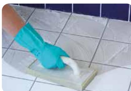
1. Nach Aushärten des Fliesenklebers kann der gesamte fertige Belag (Wand und Boden) mit dem wasser- und schmutzabweisenden Longlife-Premium Fugenmörtel **weber.fug 875 BlueComfort** verfugt werden. Dieser Fugenmörtel zeichnet sich durch eine hohe Sanitärreinerbeständigkeit aus.
