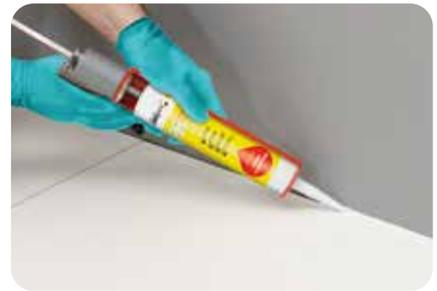
2. Anschluss- und Bewegungsfugen sind mit **weber.fug 880** oder **weber.fug 881** elastisch zu verfugen. Bei Natursteinbelägen ist **weber.fug 883** einzusetzen. Zur Haftverbesserung ist, je nach Saugfähigkeit, **weber.fug 884/885** zur verwenden.
