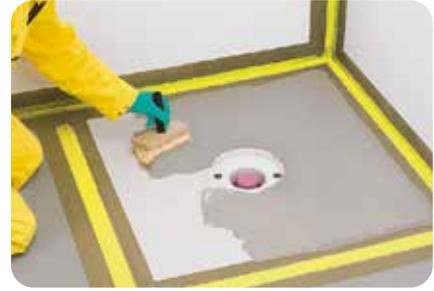
**9.** Im Anschluss daran werden das Duschwannenelement selbst und die Wandfläche abgedichtet.\*
