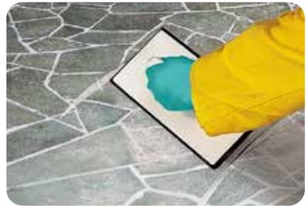
1. Nach Aushärten des Verlegemörtels kann der Belag je nach Fugenbreite mit **weber.fug 871** oder **877** verfugt werden.
