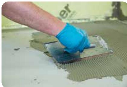
2. Im Anschluss wird auch im Bodenbereich mit einem 4 mm Zahnglätter der **weber.xerm 859 F** auf den abzudichtenden Untergrund aufgekämmt.
