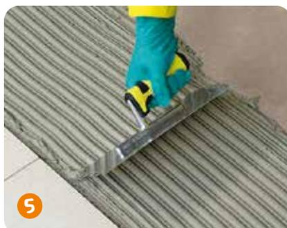
5 Nach der Durchtrocknung der Abdichtung wird z. B. der Fliesenkleber **weber.xerm 844** aufgezogen. Bevor eine Hautbildung einsetzt (aufgekämmten Klebemörtel mit dem Finger auf Klebrigkeit überprüfen), sind die Fliesen in das frische Mörtelbett einzuschieben und anzudrücken. Die Fugen sind vor Erhärten des Mörtels auszukratzen.
