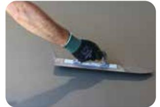
**4.** Für planebene Oberflächen ist es zwingend erforderlich, zusätzlich einen egalisierenden Spachtelauftrag mit **weber.plan 813-10** oder **weber.plan 813-25** durchzuführen. Nähere Informationen entnehmen Sie dem entsprechenden Anwendungstipp.
