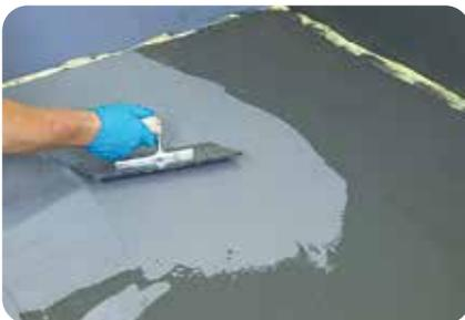
**4.** Der Gefälleestrich wird mit dem hochflexiblen 2-K Dicht-u. Klebesystem **weber.xerm 844** in 2 Arbeitsgängen abgedichtet.
