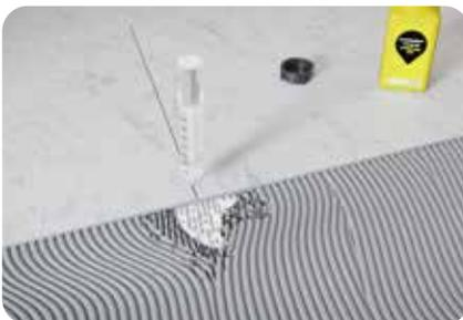
1. Nach dem Abbinden bildet **weber.sys 891** eine elastische Masse. Mehrmaliges Nachgießen ist möglich. Maximaler Zeitraum zum Nachvergießen ist 24 Std. Bei höheren Rissbreiten oder stark belasteten Flächen empfehlen wir die Verwendung von **weber.prim 806**.
