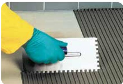
1. Auf den ausgehärteten Untergrund wird eine Kontaktschicht mit **weber.xerm 860** oder **weber.xerm 860 F** aufgespachtelt, sofort danach mit einem Kammspachtel in einem Winkel von 45–60° ein gleichmäßiges Klebebett aufgezogen.
