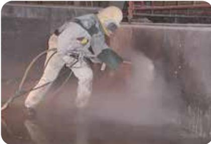
1. Gegebenenfalls sind zur Verbesserung des Haftverbundes die Untergründe mittels Schleif-, Frästechnik oder durch ein Feucht-, Sand- oder Kugelstrahlverfahren maschinell aufzurauen.
