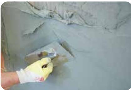
3. **weber.dur 132, 136, 137** auf den Putzgrund in der entsprechenden Dicke (10–20 mm) auftragen. Bei stark saugenden und/oder unterschiedlich saugenden Untergründen muss zweischichtig nass in nass gearbeitet werden. Die Auftragsstärke der ersten Schicht sollte dabei ca. 2/3 der Gesamtputzdicke betragen.
