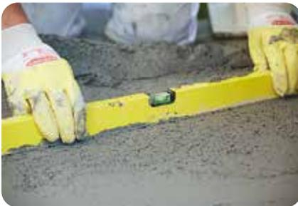
**1.** Zur Herstellung eines Verbund-Gefälleestriches wird **weber.plan 816** auf die zuvor aufgebraute frische Haftschrämme aus **weber.plan 816** und **weber.ad 785** aufgezogen.
