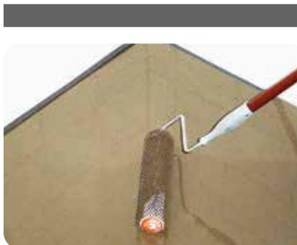
3. Anschließend wird die Nivelliermasse mit einer Glättkelle, dem Raketel oder einer Stachelwalze in der benötigten Schichtdicke gleichmäßig verteilt. Der Einsatz einer Stachelwalze bewirkt ein optimales Entlüften zur Verhinderung von Luftpfehlern in der ausgehärteten Spachtelmasse.
