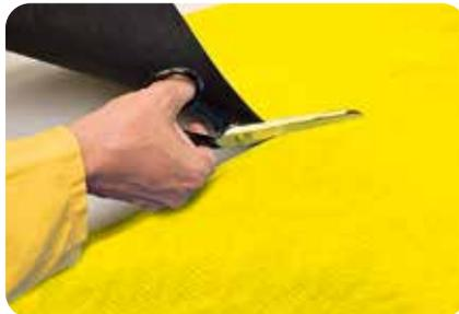
2. Die Dicht- und Entkopplungsbahn kann einfach mit einem scharfen Messer oder einer Schere geschnitten werden. Bei der Verlegung ist auf ein Verlaufen der Stöße in Gefällrichtung zu achten.
