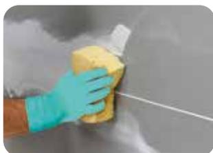
3. Das Waschen der Fugen kann mit einem Schwamm oder Schwambrett erfolgen. Zur Vermeidung von Schleierbildung oder Restmörtelrückständen ist ggf. ein zusätzlicher Reinigungsgang mit sauberem Washwasser notwendig.
