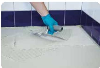
2. Nach Trocknung der Ausgleichsschicht wird eine Kontaktschicht z.B. mit **weber.xerm 861** aufgespachtelt. Sofort danach wird mit einem Kammspachtel in einem Winkel von 45–60 ° ein gleichmäßiges Klebebett aufgezogen.
