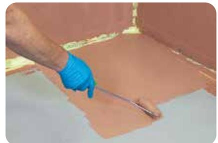
**3.** Feuchtigkeitsbeanspruchte Wandflächen, z.B. im Duschbereich, sind mit **weber.xerm 844** bzw. **weber.tec 822** (in 2 Arbeitsgängen) und den zum Dichtsystem gehörenden Dichtbändern und Manschetten **weber.tec 828** abzudichten.
