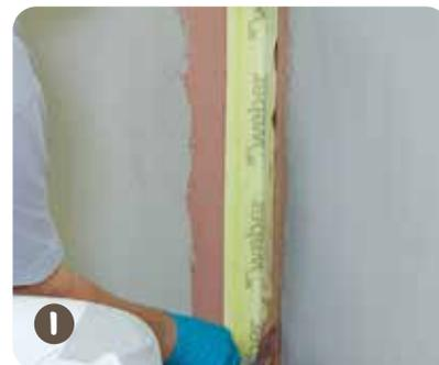
Nach vollständiger Trocknung der Grundierung wird in allen Anschlussbereichen, wie z. B. im Bereich Wand-Wand oder Wand-Boden, das elastische Dichtband **weber.tec 828 DB** eingebaut. Dazu wird das Dichtband in die Feuchtraumabdichtung eingebettet. Das überschüssige Material wird mit Spachtel oder Glätter herausgedrückt.
