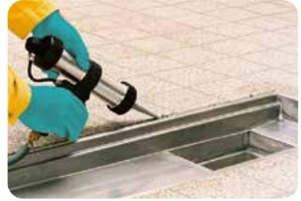
2. Anschluss- und Bewegungsfugen sind mit **weber.fug 880** elastisch zu verfugen. Zur Haftverbesserung ist, je nach Saugfähigkeit, **weber.fug 884/885** zu verwenden.
