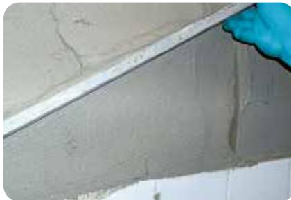
**2.** Eventuell ist ein Niveauegleich oberhalb des alten Fliesenbelags notwendig. Dieser kann mit dem Ausgleichs- und Reparaturspachtel **weber.plan 818** ausgeführt werden. Die Verlegung der Wandfliesen kann bereits nach 5 Stunden erfolgen.
