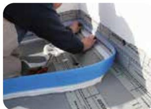
4. Nach Trocknung der mineralischen Dichtungsschlämme empfiehlt sich zur Ausbildung von Randbewegungsfugen das Anbringen eines geeigneten Randeddämmstreifens.
