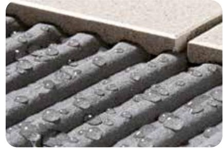
2. Das wasserdichte und gleichzeitig hochflexible Dicht- und Klebesystem vermittelt Sicherheit und spart Zeit und Geld. **weber.xerm 844**, ein durchgehend dichtes System.
