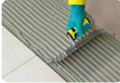
5. Nach der Durchtrocknung der Abdichtung wird z.B. der Fliesenkleber **weber.xerm 844** aufgezogen. Bevor eine Hautbildung einsetzt (aufgekämmten Klebemörtel mit dem Finger auf Klebrigkeit überprüfen), sind die Fliesen in das frische Mörtelbett einzuschieben und anzudrücken. Die Fugen sind vor Erhärten des Mörtels auszukratzen.
