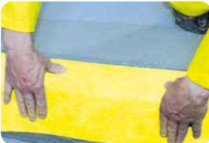
1. Eventuell vorhandene Stirnseiten werden mit dem Dichtband **weber.tec 828 DB** abgedichtet. Die Verklebung des Dichtbandes erfolgt mit **weber.xerm 860 F**. Gegebenenfalls ist ein Fliesenabschlussprofil einzukleben und zu verdübeln.
