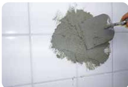
1. Lose oder beschädigte Fliesen sind zu entfernen. Entstandene Fehlstellen können mit weber.plan 818 flächenbündig ausgebessert werden.
