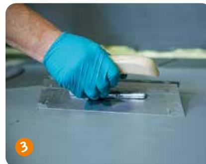
3 Der 1. Auftrag aus der flexiblen Dichtungsschlämme **weber.xerm 844** sollte mit einer festen Bürste oder einem Quast erfolgen. Nur so ist sichergestellt, dass kleinste Poren oder Lunkerstellen gefüllt und geschlossen werden.
