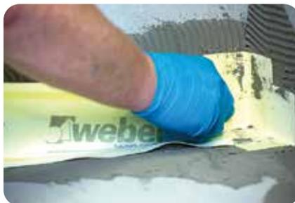
1. Nach vollständiger Trocknung der Grundierung wird in allen Anschlussbereichen das elastische Dichtband **weber.tec 828 DB** eingebaut. Dazu wird das Dichtband in das Mörtelbett aus **weber.xerm 859 F** eingebettet und mit Spachtel oder Glätter angedrückt.
