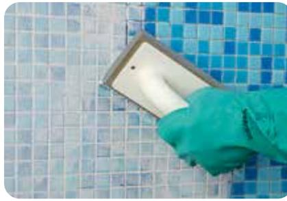
1. Danach werden die Fugen mit **weber.xerm 848** und mit Hilfe eines Epoxi-Fugbretts eingefügt.
