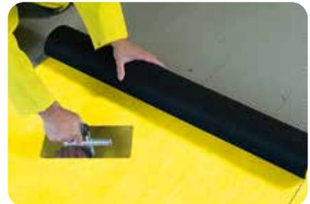
3. Mit einem Kammspachtel (6 mm Zahnung) wird in einem Winkel von 45°-60° ein gleichmäßiges Kleberbett mit **weber.xerm 860 F** aufgezogen und **weber.tec 826** in das frische Kleberbett mittels Glätter eingedrückt. Bahn stumpf stoßen.
