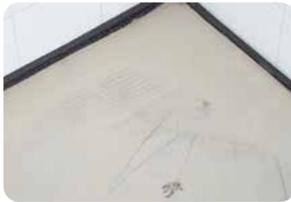
2. Der direkte Anschluss der Bodenfläche zu angrenzenden Bauteilen (z.B. Wänden, Rohrdurchführungen usw.) muss durch den Einbau eines Randdämmstreifens verhindert werden.
