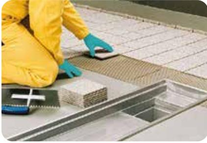
1. Die Fliesen müssen innerhalb der klebeoffenen Zeit in den Kleber eingelegt werden. Dabei empfiehlt es sich, den EP-harzgebundenen Kleber **weber.xerm 847** zu verwenden. Auch eine Verklebung mit **weber.xerm 860 F** ist in Abhängigkeit von der Beanspruchung möglich.
