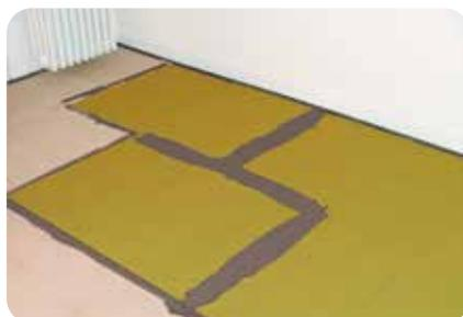
2. Die Verlegung von **weber.sys 830** erfolgt im Halbverband, Kreuzfugen sind zu vermeiden! Die Matten können einfach mit Messer oder Schere geschnitten und eingepasst werden.
