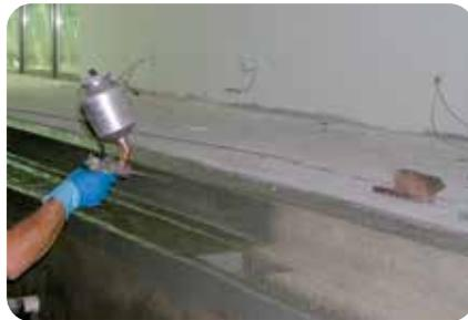
4. Der zweite Arbeitsgang erfolgt zwischen dem 1. und 3. Tag. Wenn nicht innerhalb von 5 Tagen der Fliesenbelag mit **weber.xerm 847** verklebt wird, wird in den noch frischen 2. Auftrag **weber.tec 827** (Schichtdicken 0,3 bis 0,5 mm) Quarzsand eingestreut.
