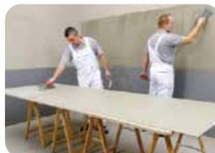
**2.** Bei steigenden Formatgrößen wird es bei der Dünnbettverlegung immer schwieriger, eine vollflächige Benetzung zu erreichen. Deshalb ist es zwingend erforderlich, das kombinierte Verlegeverfahren (buttering-floating) zu wählen. Größere Formate erfordern einen steigenden Klebemörtelverbrauch.
