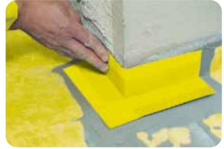
6. Im Eck-, Dehn-, Stoß- und Bewegungsfugenbereich werden zunächst in den frisch vorgelegten Klebemörtel aus **weber.xerm 844** oder **weber.xerm 860 F** die Dichtbandkomponenten **weber.tec 828** eingebettet. Das Dichtband wird ca. 5 bis 8 cm überlappend verlegt.\*
