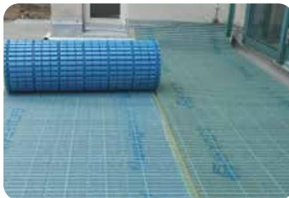
**5.** Zur Verbesserung der horizontalen Entwässerung wird die Dränmatte Gutjahr Aquadrän EK auf die erhärtete Abdichtung lose verlegt.
