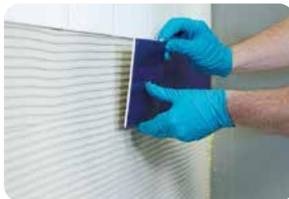
5. Bevor eine Hautbildung einsetzt (aufgekämmten Klebemörtel mit dem Finger auf Klebrigkeit überprüfen), sind die Fliesen in das frische Mörtelbett einzuschieben und anzudrücken.
