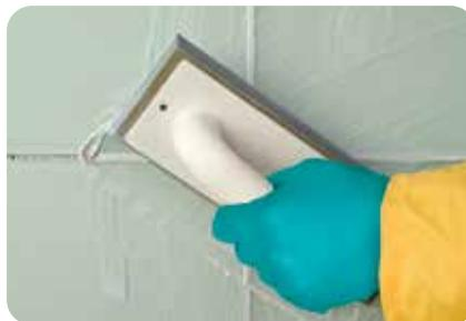
1. Nach Aushärten des Verlegemörtels kann der Belag mit **weber.fug 875 BlueComfort** verfugt werden. Um ein zu starkes Auswaschen der Fugen zu vermeiden, muss gegebenenfalls mit einem dafür geeigneten Schwamm abgewaschen werden.
