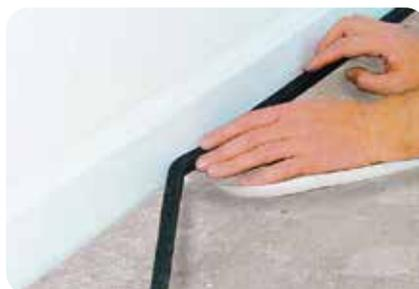
2. Um Schallbrücken und Spannungen zu vermeiden, muss ein direkter Kontakt des Estrichs zu angrenzenden Bauteilen durch den Einbau eines Randdämmstreifens verhindert werden. Erst nach Fertigstellung des Oberbelages dürfen die überstehenden Randstreifen abgeschnitten werden.
