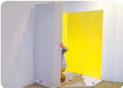
Der Aufbau einer vorgefertigten Dampfkabine ist denkbar einfach: Nachdem das Bodenelement waagrecht eingebaut und an den Abfluss angeschlossen wurde, werden die einzelnen Wandelemente, auf die bereits werkseitig eine Dampfsperre aufgebracht wurde, in Nut- und Federtechnik miteinander verklebt.
