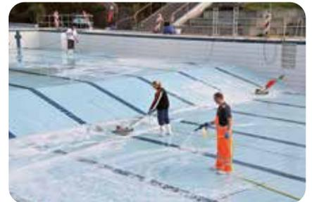
Vor der Inbetriebnahme des Beckens wird dieses mindestens zwei Wochen lang mit einer erhöhten Chlorkonzentration (mind. 2 mg/l) gefahren. Soll das Becken anschließend mit einer chlorfreien Wasseraufbereitung gefahren werden, muss das Becken regelmäßig optisch kontrolliert werden. Bei den geringsten Anzeichen von Organismen an Beckenwänden oder Beckenboden ist eine Stoßchlorung durchzuführen.
