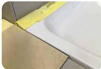
7. **weber.tec 828 ME SK** kann je nach Einbausituation vom Fliesenleger an der Perforation geklappt oder wenn nötig auch eingeschnitten werden. Somit ergeben sich variable Möglichkeiten der Anbindung einer Außen-ecke an die Abdichtungsschicht, auch bei bodenbündigem Einbau der Duschwanne.
