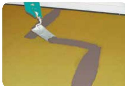
3. Die Mattenstöße können während der Verlegung in einem Arbeitsgang mit **weber.xerm 844** und einer Spachtel- oder Glättkelle geschlossen werden. Dadurch werden Schallbrücken vermieden. Ein Abkleben der Stöße mit Klebeband ist dann nicht mehr nötig.
