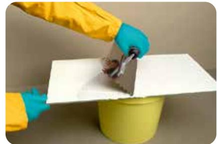
2. Bevor die Glasfliesen auf den planebenen Untergrund verlegt werden können, wird die Rückseite mit Fliesenkleber vollflächig abge-spachtelt.
