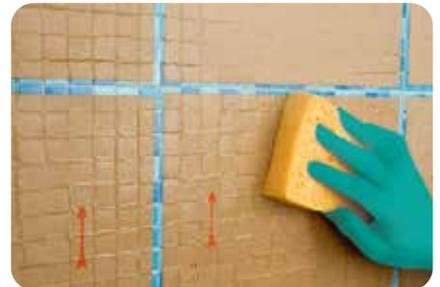
4. Bevor der Kleber abbindet, wird das vorhandene aufgeklebte Papier angefeuchtet und vorsichtig abgezogen.
