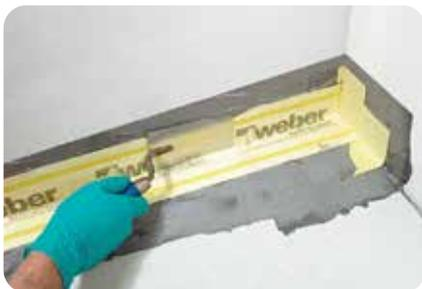
1. Nach der Untergrundüberprüfung (siehe Anwendungstipp A.04.), ist der Untergrund zu grundieren und für die weiteren Arbeitsschritte vorbereitet. Die Dichtbandkomponenten **weber.tec 828** werden im Wandanschlussbereich mit **weber.xerm 844** eingeklebt und an den Randzonen überarbeitet.\*
