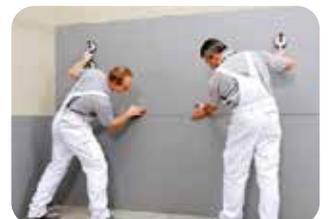
**1.** Nachdem der Fliesenkleber im Wandbereich sowie auf der Rückseite der Keramik vollflächig aufgekämmt wurde, kann die Keramik in das frische Mörtelbett aus **weber.xerm 861** eingesetzt werden. Mit entsprechend leichtem Nachklopfen oder Einschleiben sollte eine möglichst volle Benetzung angestrebt werden.
