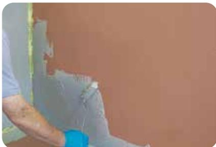
5. Nach Trocknung des ersten Auftrages kann der zweite Auftrag mit **weber.tec 822** erfolgen. Die Trockenschichtdicke der Abdichtungsschicht muss min. 0,5 mm betragen.\*
