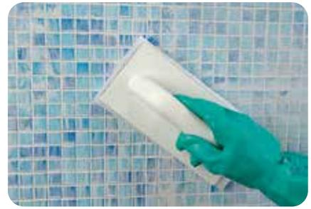
2. Abschließend wird im ersten Waschgang mit einem weißen Pad das Glasmosaik vorgewaschen und im zweiten Schritt mit einem Schwamm abgewaschen.
