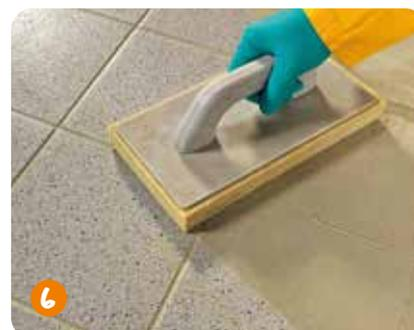
6 Nach Aushärten des Fliesenklebers kann der fertige Belag mit z. B. **weber.fug 877** verfugt werden.
