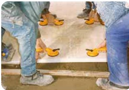
4. Großformatige Platten werden mit Verlegehilfen eingelegt und wenn nötig auf die erforderliche Belagshöhe eingeklopft.
