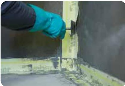
2. Alle Durchdringungen, Anschluss- und Bewegungsfugen, auch im Wand-/Bodenbereich, werden mit dem entsprechenden Dichtbandsystem **weber.tec 828** abgedichtet.\*
