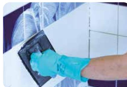
1. Nach Aushärten des Fliesenklebers kann der gesamte fertige Belag (Wand und Boden) mit dem wasser- und schmutzabweisenden Longlife-Premium Fugenmörtel **weber.fug 875 BlueComfort** verfugt werden. Dieser Fugenmörtel zeichnet sich durch eine hohe Sanitärreinigerbeständigkeit aus.
