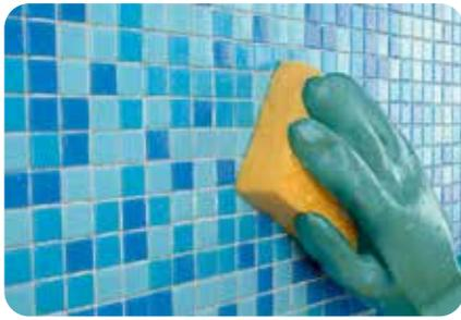
5. Nach der Abbindephase wird der Belag mit einer Chlorbleichlauge gereinigt und mit klarem Wasser gründlich nachgewaschen, um spätere Verkeimung in den Fugen, insbesondere in Schwimmbecken, zu vermeiden. Besonders im Bodenbereich ist es wichtig, dass die Fugen vor Schmutz- und Überschusswasser freizuhalten sind.
