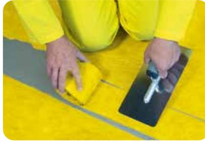
5. Danach wird das Dichtband in das frisch aufgezogene Kleberbett eingelegt und mit einer Glättkelle eingedrückt und abgezogen, sodass überschüssige Mörtelreste entfernt werden.
