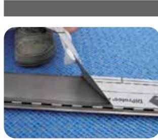
**7.** Hierzu rückseitig auf die Drainrinne DiProtec® AB-KV aufkleben und Klebemörtelpunkte auftragen. In diesem Bereich wird die Dünnschichtdrainage Watec® Drain KP ausgespart.
