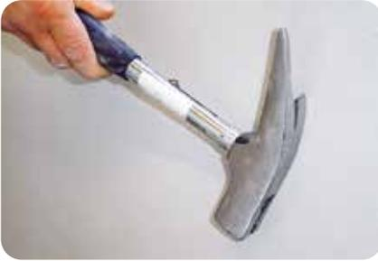
1. Zur Erkennung von Hohlstellen sollte der Untergrund mit einem stumpfen Hammer abgestreift und abgeklopft werden. Im Bereich von Hohlstellen zeigt sich ein dunkler Klang. Hohlstellen sind durch geeignete Maßnahmen zu beheben.
