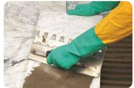
2. Bei nicht kalibrierten Naturwerksteinplatten sowie allen Natursteinmaterialien, die zur Verfärbung neigen können, ist zunächst eine Kratzspachtelung mit **weber.xerm 866 F** auf der Rückseite auszuführen.
