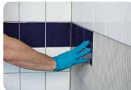
2. Bevor eine Hautbildung einsetzt (aufgekämmten Klebemörtel mit dem Finger auf Klebrigkeit überprüfen) sind die Fliesen in das frische Mörtelbett einzuschieben und anzudrücken.
