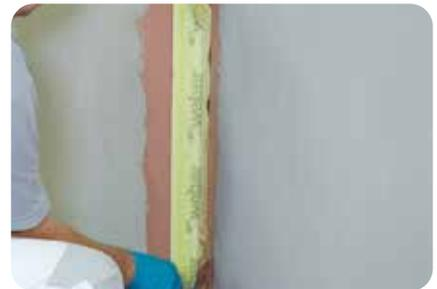
1. Nach vollständiger Trocknung der Grundierung wird in allen Anschlussbereichen, wie z.B. im Bereich Wand-Wand oder Wand-Boden, das elastische Dichtbandsystem **weber.tec 828** eingebaut. Dazu wird das Dichtband in die Feuchtraumabdichtung eingebettet. Das überschüssige Material wird mit Spachtel oder Glätter herausgedrückt.
