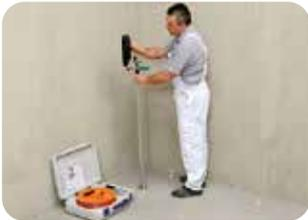
**1.** Bodenflächen mittels elektr. Schlauchwaage oder Lasergerät auf Ebenflächigkeit überprüfen. Zur besseren Orientierung sind ggf. Fixpunkte anzulegen, die beim Ausgleich den nötigen Materialauftrag aufzeigen und eine optimale Ebenflächigkeit gewährleisten.
