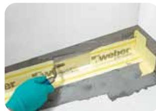
1. Im Eck-, Dehn- und Bewegungsfugenbereich werden die Dichtbandkomponenten **weber.tec 828** in die frisch vorgelegte mineralische Dichtungsschlämme aus **weber.xerm 844** eingebettet. Der Anschluss von Tür- oder evtl. vorhandenen Fensterrahmen erfolgt mit dem selbstklebenden Dichtband **weber.tec 828 SK**.
