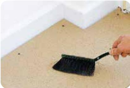
1. Die Bodenfläche muss trocken, fest, sauber und schwingungsfrei sein. Haftungsmindernde Verunreinigungen auf der Oberfläche des Untergrundes sind sorgfältig zu entfernen.
