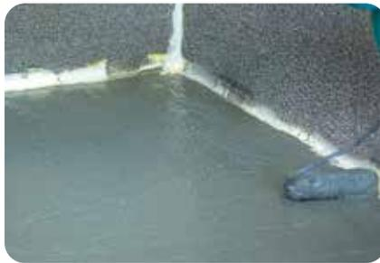
2. Die Verbundabdichtung wird in 2 Arbeitsgängen mit der flexiblen Reaktionsharzabdichtung **weber.tec 827** ausgeführt.
