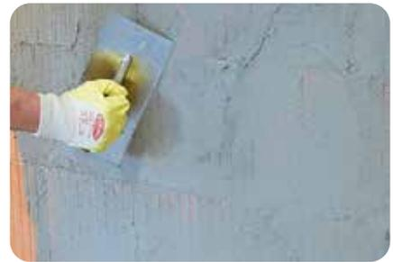
2. Mit dem Profil-Ansetzmörtel **weber.mix 125** Mörtelbatzen auftragen und Profile sofort einsetzen und ausloten. Grundsätzlich sind Unterputz- und Eckprofile in Feuchträumen in Edelstahl auszuführen.
