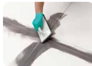
2. **weber.fug 875 BlueComfort** mit dem Fugbrett bündig und tief in die Fugen einarbeiten. Nach wenigen Minuten nochmals etwas Fugemörtel auftragen und die Oberfläche sauber diagonal abziehen, überschüssiges Material entfernen.
