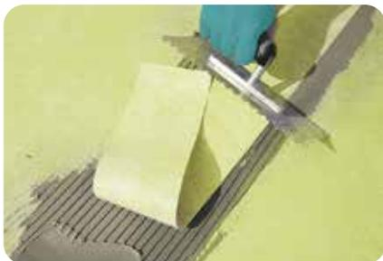
4. Die Bahnen aus **weber.tec 825** werden stumpf gegeneinander gestoßen. Die Übergänge der Fugenstöße werden mit einem Schleppstreifen aus **weber.tec 828 DB** überarbeitet. In hochbeanspruchten Bereichen muss die Verklebung mit **weber.tec 827 S** durchgeführt werden.
