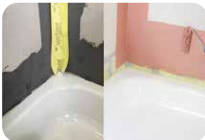
6. Die noch frische Abdichtungsschicht vollflächig abglätten, sodass keine Falten oder überschüssiges Abdichtungsmaterial Unebenheiten verursachen. Dichtband mit mind. 5 cm Überlappung verkleben.
