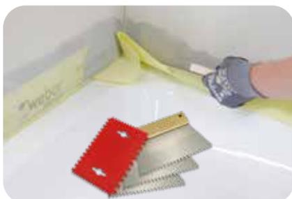
5. Die Verklebung der Dichtbänder am Untergrund ist ebenfalls mit **weber.tec 821** möglich. Hierbei empfiehlt sich zum Auftrag ein feiner Zahnsachtel.
