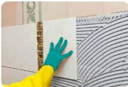
1. Bevor eine Hautbildung einsetzt (aufgekämmten Klebemörtel mit dem Finger auf Klebrigkeit überprüfen) sind die Fliesen in das frische Mörtelbett einzuschieben und anzudrücken. Die Fugen sind vor Erhärten des Mörtels auszukratzen.
