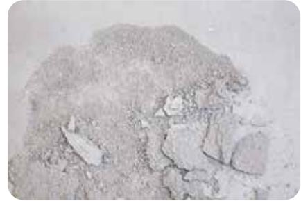
2. Platzt eine Schale aus der Oberfläche heraus, muss die Oberfläche durch geeignete Maßnahmen (schleifen, fräsen) von den Ablagerungen befreit werden.
