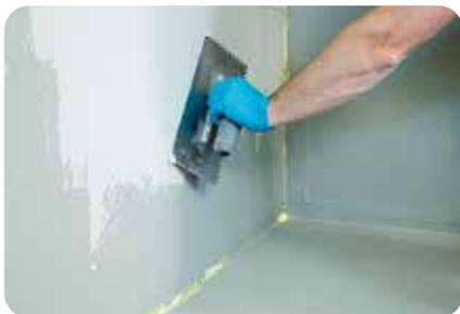
4. Nach Trocknung der Ausgleichsschicht wird eine Kontaktschicht z.B. mit **weber.xerm 861** aufgespachtelt. Sofort danach wird mit einem Kammspachtel in einem Winkel von 45–60 ° ein gleichmäßiges Klebebett aufgezogen.
