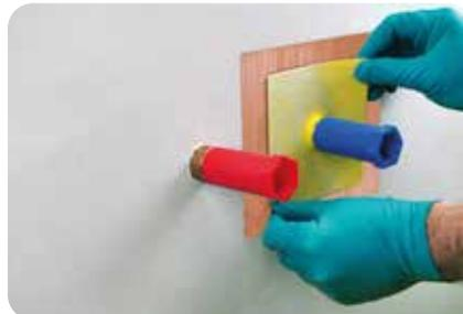
3. Zur Abdichtung an Sanitäranschlüssen müssen die speziellen Manschetten **weber.tec 828 MDK** eingesetzt werden.
