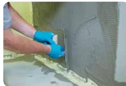
2. Mit einem 4 mm Zahnglätter wird **weber.xerm 859 F** auf den abzudichtenden Untergrund aufgekämmt.
