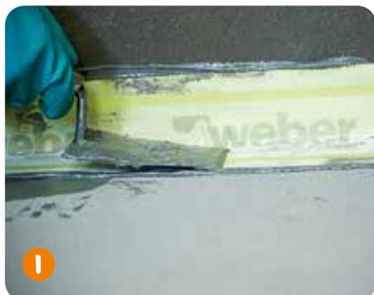
1 Im Eck-, Dehn-, Stoß- und Bewegungsfugenbereich werden die Dichtbandkomponenten **weber.tec 828** zunächst in die frisch vorgelegte Dichtungsschlämme aus **weber.xerm 844** eingebettet.\*
