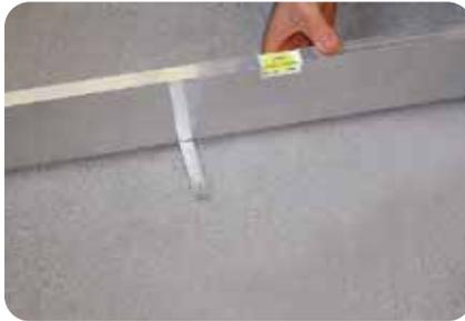
1. Mit Hilfsmitteln wie Zollstock, Wasserwaage, Richtlatte, Schnur, Senklot oder Laser-Nivelliergerät, wird die Maßhaltigkeit des Untergrundes überprüft.
