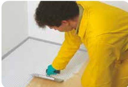
2. Mit einem Kammspachtel (Zahnung 6 x 6 mm) wird **weber.xerm 860 F** oder **weber.xerm 843** auf den Untergrund aufgekämmt.
