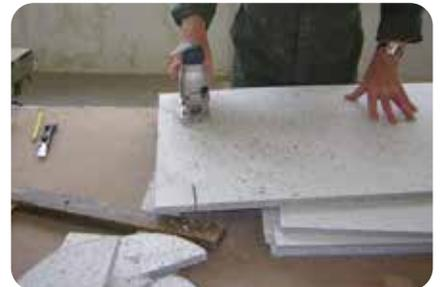
3. Die Platten können einfach mit einem Cuttermesser oder einer Stichsäge geschnitten werden. Sie werden in den frisch aufgetragenen Kleber eingelegt. Die Verlegung erfolgt im Halbverband, Kreuzfugen sind zu vermeiden! Matten dicht stoßen!
