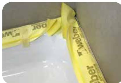
1. Im Zuge der Abdichtungsarbeiten kann der Fliesenleger nun die vorgeklebten Dichtbandvarianten auf dem mit **weber.prim 801** grundierten Untergrund in die Wand-/Flächenabdichtung aus **weber.xerm 844** mit einbinden.
