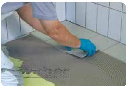
3. Nach der Verlegung der Wandfliesen erfolgt die Bodenverlegung, ebenfalls mit **weber.xerm 859 F**. Es ist darauf zu achten das eine ausreichend große Zahnung verwendet wird, um ein vollsattes Mörtelbett zur gewährleisten.
