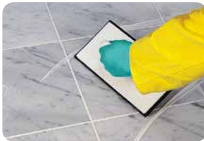
1. Nach Aushärten des Naturstein-Klebermörtels kann der fertige Belag mit dem flexibel eingestellten Fugenmörtel **weber.fug 875 F** verfugt werden.
