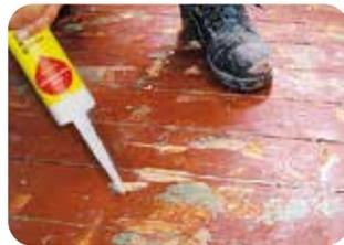
**2.** Offene Stoßfugen müssen durch geeignete Maßnahmen (z.B. Ausspritzen mit einem Acryl-Fugendichtstoff z.B. **weber.fug 888**) geschlossen werden.
