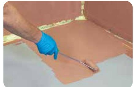
4. Anschließend wird der erste Flächenauftrag mit **weber.tec 822** aufgebracht. Das Material lässt sich mit dem Glätter, Pinsel oder einer Lammfellrolle auftragen.
