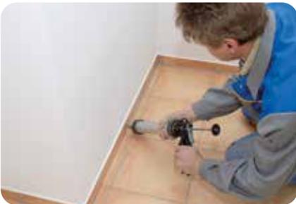
7. Anschluss- und Bewegungsfugen sind mit **weber.fug 880** oder **weber.fug 881** elastisch zu verfugen. Bei Natursteinbelägen ist **weber.fug 883** einzusetzen. Zur Haftverbesserung ist, je nach Saugfähigkeit, **weber.fug 884/885** zu verwenden
