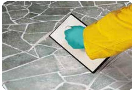
1. Der Trass Natursteinfugenmörtel **weber.fug 871** eignet sich auch zur Verfugung von polygonal verlegtem Naturwerkstein.
