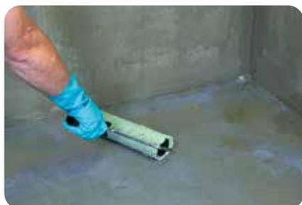
1. Zur Verbesserung des Haftverbundes sind mineralische Untergründe maschinell aufzurauen mittels Schleiftechnik, oder durch ein Sandstrahl-, oder Kugelstrahlverfahren. Nach der Reinigung ist der Untergrund mattfeucht vorzunässen.
