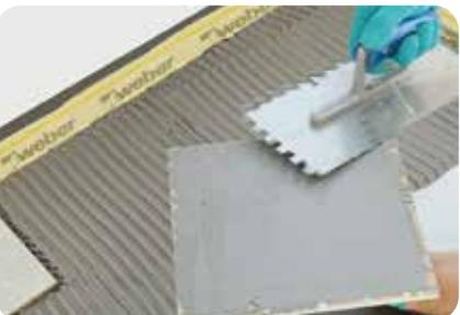
1. Um eine möglichst hohlräumfreie Bettung zu erzielen, kann in Außenbereichen auch eine Verlegung im buttering-floating-Verfahren angewendet werden. Dies ist jedoch abhängig von Größe und Rückseite des Verlegeguts. Zudem trägt diese Verlegeart zusätzlich zur Dichtheit der Gesamtkonstruktion bei. So wird die Durchfeuchtung der Konstruktion vermieden und das Risiko von Ausblühungen minimiert.
