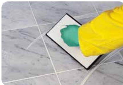
1. Nach Aushärten des Verlegemörtels kann der Belag mit **weber.fug 877** oder **weber.fug 875 F** verfugt werden.
