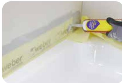
4. Bei Abdichtungsarbeiten mit flüssiger Dichtfolie, **weber.tec 822** können die Dichtbandkomponenten statt mit **weber.xerm 844** auch mit **weber.tec 821** verklebt werden.
