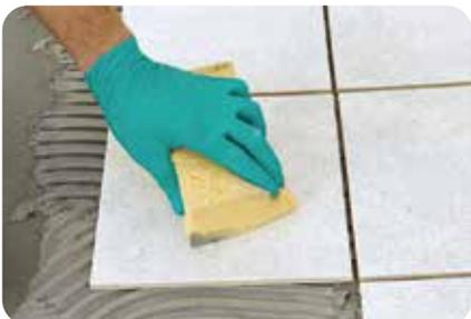
2. Mörtelreste auf Sichtoberflächen und im Fugenbereich sind sofort mit Schwamm und Wasser zu entfernen. Hartnäckigere Materialanhaftungen lassen sich mit **weber.sys 992** entfernen.
