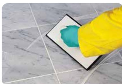
1. Nach Aushärten des Fliesenklebers kann der fertige keramische Belag mit **weber.fug 875 BlueComfort**, Natursteinbelag mit **weber.fug 875 F** verfugt werden.
