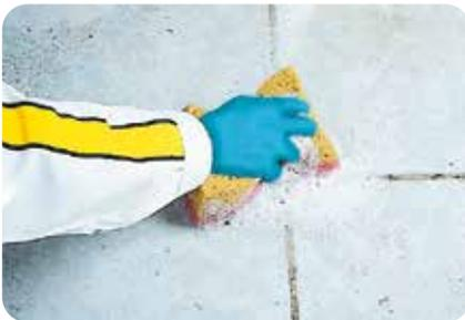
**1.** Haftungsmindernde Verunreinigungen auf der Oberfläche des alten Fliesenbelages sind sorgfältig zu entfernen. Fettige und ölige Bestandteile sind mit fettlösendem Reiniger zu entfernen.
