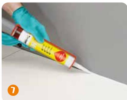
7 Anschluss- und Bewegungsfugen sind mit **weber.fug 880** oder **weber.fug 881** elastisch zu verfugen. Bei Natursteinbelägen ist **weber.fug 883** einzusetzen. Zur Haftverbesserung ist, je nach Saugfähigkeit, **weber.fug 884/885** zu verwenden.
