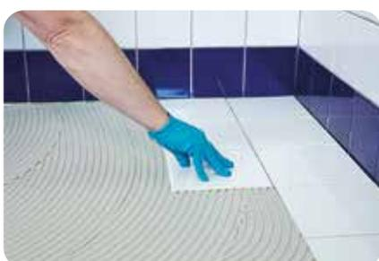
3. Nach Durchtrocknung der Verbundabdichtung kann der Flexklebemörtel, Universal **weber.xerm 861** auch im Bodenbereich aufgezogen werden. Auch hierbei werden die Fliesen in das frische Mörtelbett eingeschoben und eingedrückt. Die Fugen sind vor Erhärten des Mörtels auszukratzen.
