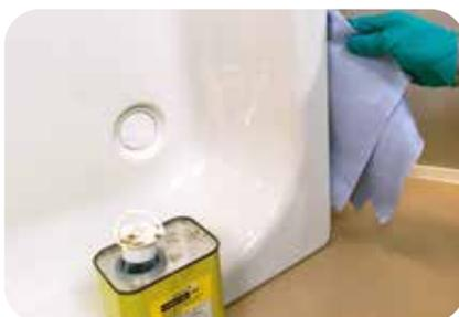
1. Untergrund/Klebefläche der Duschwanne mit einem Reinigungstuch sorgfältig entfetten und z.B. mit Aceton reinigen.
