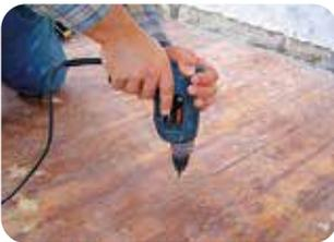
**1.** Zur Erhöhung der Tragfähigkeit muss der Holzuntergrund ausreichend mit der Unterkonstruktion verschraubt werden (Schraubenabstand max. 40 cm).
