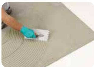
1. Großformatige, dünne Fliesen müssen mit einer rückseitigen Gewebekaschierung versehen sein, um diese im Bodenbereich zu verwenden. Hierbei erfolgt die Verlegung ebenfalls im buttering-floating-Verfahren mit **weber.xerm 859 F**.
