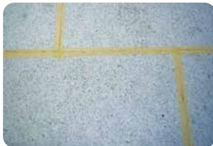
5. Die entstandenen Stoßfugen zwischen den einzelnen Platten sind mit Kreppband abzukleben.
