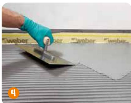
4 Der 2. Auftrag der flexiblen Dichtungsschlämme kann mit einer Glättkelle satt und gleichmäßig aufgetragen werden. Die Mindeststrockenschichtdicke der Abdichtungsschicht muss mind. 2,0 mm betragen.
