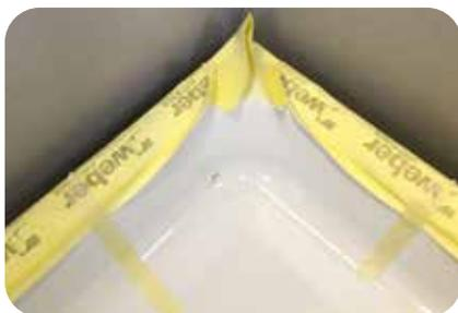
3. Die so hergestellte Abdichtung an der Dusch-/Badewanne wird nach unten geklappt und mit einem Klebeband fixiert. So kann diese dann vom Installateur eingebaut werden.
