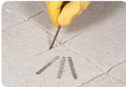
2. Nach gründlicher Entfernung von Staub und anderen haftungsmindernden Bestandteilen werden Rissfixierungsklammern in die Querschnitte eingesetzt.
