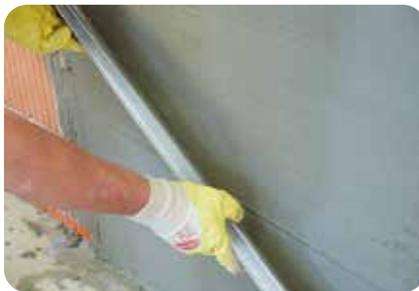
4. Den frisch aufgetragenen Putzmörtel latentecht und nestfrei abziehen. Die fertige Putzoberfläche muss für die anschließende Aufnahme von Fliesen und Platten eben und rau sein. Glatte Putzoberflächen sind zu vermeiden.
