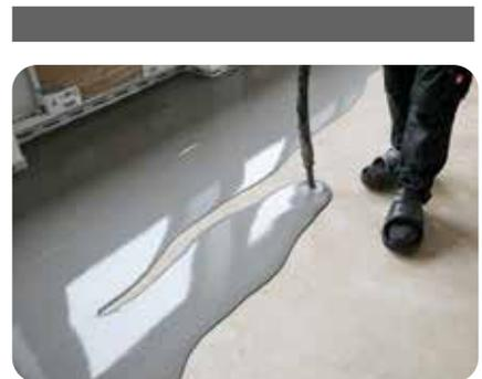
4. Auf größeren Flächen ist das Einbringen der Nivelliermasse mit entsprechender Maschinenteknik im Pumpverfahren zu empfehlen.
