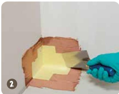
Die Eckausbildungen werden dabei am einfachsten mit Hilfe der vorgefertigten Dichtecken ausgeführt.
