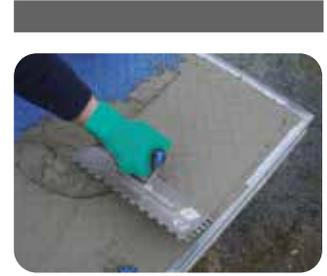
**9.** Das Armierungsgewebe der oberen Tragschicht (ca. 3 mm) Zug um Zug z.B. mit **weber.xerm 860 F**, ausspachteln, ...
