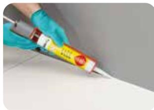
4. Anschluss- u. Bewegungsfugen sind mit **weber.fug 880** oder **881** elastisch zu verschließen. Alternativ können entsprechende Profile verwendet werden. Zur Haftverbesserung ist, je nach Saugfähigkeit, **weber.fug 884/885** zur verwenden.
