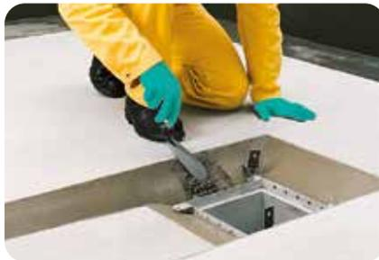
1. Der Edelstahl-Bodenablauf wird in die vorgesehene Aussparung eingesetzt und mit dem schnell abbindenden Estrichmörtel **weber.plan 816** vermörtelt.
