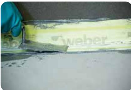
**1.** Im Eck-, Dehn-, Stoß- und Bewegungsfugenbereich werden die Dichtbandkomponenten **weber.tec 828** zunächst in die frisch vorgelegte Dichtungsschlämme aus **weber.xerm 844** eingebettet.\*
