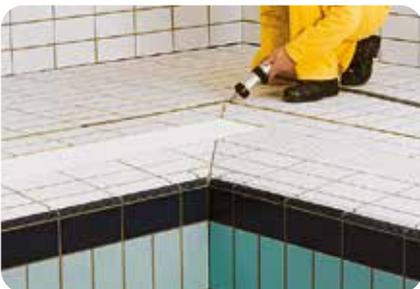
2. Anschluss- und Bewegungsfugen sind mit **weber.fug 880 Fliesen-Silikon** elastisch zu verfugen. Zur Haftverbesserung ist, je nach Saugfähigkeit, **weber.fug 884/885** zu verwenden.
