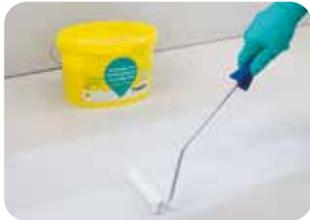
**2.** Beim Calciumsulfatestrich darf das Anmachwasser des Klebers nicht in den Untergrund gelangen. Die Restfeuchte darf vor der Verlegung max. 0,5 CM-% betragen. Bei diesem Untergrund ist die schnelle Multifunktionsgrundierung, **weber.prim 804** im zweimalem Auftrag aufzubringen.
