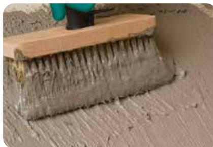
1. Die Trass-Haftbrücke ist in einer schlammfächtigen Konsistenz mit einem Besen aufzustreichen. Hierzu wird das Pulver mit ca. 50 Gew.-% Wasser angemischt.
