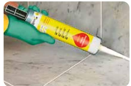
2. Anschluss- und Bewegungsfugen sind mit **weber.fug 883** Naturstein-Silikon elastisch zu verfugen. Zur Haftverbesserung ist, je nach Saugfähigkeit, **weber.fug 884/885** zu verwenden.
