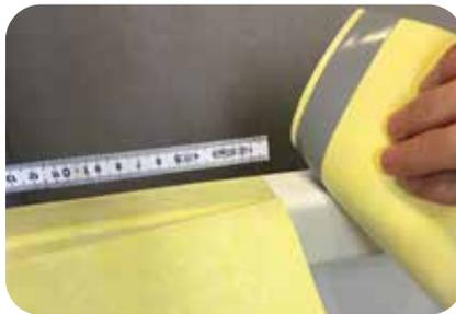
1. **weber.tec 828 SK** wird fortlaufend zum Wandanschluss mit dem Butylklebestreifen von hinten mit 5 cm Überlappung auf die Dichtecken und auf den Rand des Wannenkörpers geklebt und fest angedrückt.
