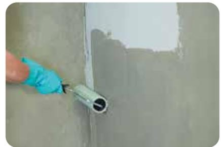
5. Nach Trocknung des Putzes (ca. 1 Tag/1 mm Putzstärke) die Putzoberfläche mit einem Besen oder Handfeger kräftig abfeigen. Danach mit **weber.prim 801** vollflächig grundieren. Feuchtigkeitsbeanspruchte Bereiche sind mit einer geeigneten Verbundabdichtung zu schützen.
