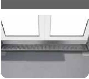
**6.** Zur DIN-Norm-gerechten Ausführung an niedrigen Türschwellen, Verringerung von 15 auf 5 cm, kommt die extrem flache Drainrinne Watec® Drain RD-QE zum Einsatz.
