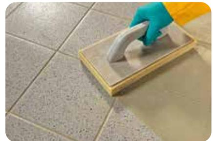
1. Nach Aushärten des Fliesenklebers kann der fertige Belag z.B. mit **weber.fug 877** verfugt werden.
