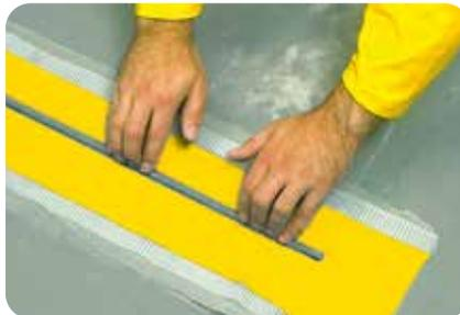
1. Bei Bewegungsfugen wird das Fugendichtband **weber.tec 828 DB 150** schlaufenförmig mit **weber.tec 827** aufgeklebt und entsprechend überarbeitet.
