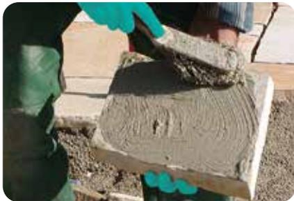
2. Die Verlegung der Naturwerksteinplatten erfolgt frisch in frisch in den Dränmörtel. Die Trass-Haftbrücke **weber.xerm 867** wird dazu vorher auf die Rückseite der Platten aufgetragen.
