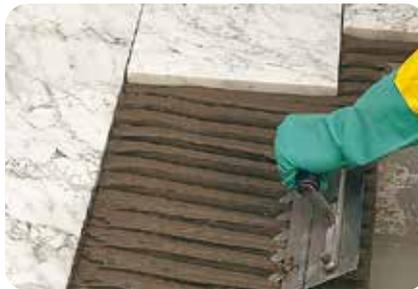
1. Auf den Untergrund wird eine Kontaktschicht mit **weber.xerm 866 F** aufgebracht. Sofort danach mit einer geeigneten Kammspachtelung in einem Winkel von 45–60° ein gleichmäßiges Kleberbett aufziehen.
