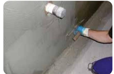
2. Die Abdichtung **weber.tec 827** wird mit der Spitzzahnleiste (Zahnung 2,5 mm) zur Mengenkontrolle aufgetragen und anschließend gleichmäßig dick abgezogen, Schichtdicke 1 bis 1,5 mm.
