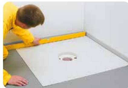
**6.** Das Duschwannenelement wird in Höhe und Ebene eingebaut. Es muss vollständig auf dem Untergrund aufliegen.
