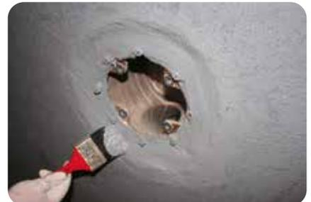
3. Anschließend werden diese mit **weber.xerm 844** eingedichtet.
