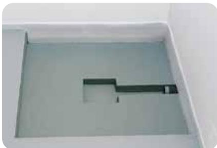
**1.** Für den Einbau des Duschwannenelementes **weber.sys 833** ist eine Mindesttiefe von 43 mm unter OK Rohfußboden erforderlich. Im Bereich des Ablauftropfes und der ggf. horizontalen Abwasserleitung sind die im Bild 2 aufgeführten Aufbauhöhen erforderlich. Aussparung für den Ablauftropf: ca. 20 cm x 20 cm, für das Abflussrohr: ca. 8 cm
