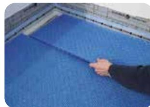
5. Die Watec® Drain KP Dünnschichtdrainagen werden lose auf der Abdichtungsebene, Stoß an Stoß ausgelegt und ohne Zwangsspannungen bis an den Randstreifen angearbeitet. \*)
