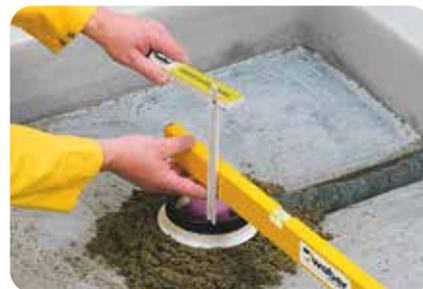
**3.** Die Verbindung zwischen dem vorhandenen Abflussrohr und dem Ablauf wird mit einem bauseitigen PVC-Rohr, umwickelt mit Schallschutzband, hergestellt. Rohr und Ablauf vor dem Einbau des Ausgleichestrichs ggf. fixieren. Dabei liegt die Oberkante des Ablauftropfes ca. 50 mm unterhalb der Oberkante des vorhandenen Estrichs. Für einen lagegenauen Einbau des Ablauftopfes kann das Duschwannenelement selbst als Schablone dienen.
