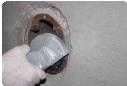
2. Edelstahlteile werden gereinigt und angeschliffen.
