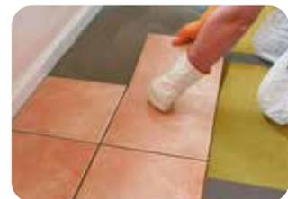
**4.** Nach Durchtrocknung der Spachtelmasse können nachfolgend Oberbeläge verlegt werden. Zur Aufnahme von keramischen Belägen und Naturstein, sollte der Belag zunächst durch den Einbau des Trittschalldämm- und Entkopplungssystems **weber.sys 830/832** entkoppelt werden.
