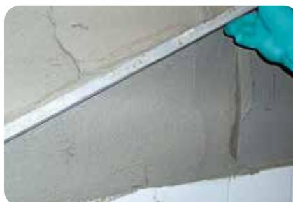
3. Danach den frisch aufgetragenen Mörtel in der notwendigen Schichtdicke auftragen, anschließend lattenrecht und nestfrei abziehen. Wenn nötig kann die angesteifte Mörtelschicht abgerieben werden.
