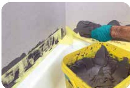
2. Im Anschluss werden die Dichtbandvarianten in die frische Abdichtungsschicht aus **weber.xerm 844** vollflächig eingebettet und geglättet. Dies erfolgt auf allen abzudichtenden Seiten der Dusch-/Badewanne.
