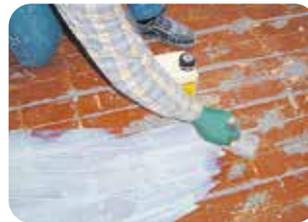
**3.** Holzuntergründe werden zunächst mit **weber.prim 803** grundiert. Spanplatten (mindestens Typ V100G) und unbehandelte Holzdielen müssen mit **weber.prim 807** und Sandabstreuvung grundiert werden.
