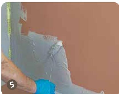
Nach Trocknung des ersten Auftrages kann der zweite Auftrag mit **weber.tec 822** erfolgen. Die Trockenschichtdicke der Abdichtungsschicht muss min. 0,5 mm betragen.\*
