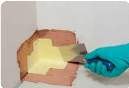
2. Die Eckausbildungen werden dabei am einfachsten mit Hilfe der vorgefertigten Dichtecken ausgeführt.
