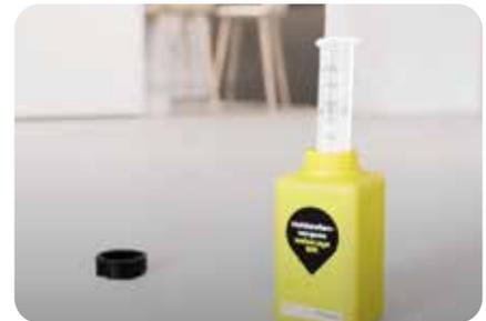
1. Mit geeigneten Hilfswerkzeugen, wie Trichter, Quetschflasche, Vorratsbehälter oder Pipette usw. wird nun die Spezialflüssigkeit in den geöffneten Belag gegossen. Hier kann es, je nach Hohlstellengröße, zu mehreren Arbeitsschritten kommen. Die Spezialflüssigkeit wird in Abständen (ca. 20–30 Min.) solange nachgegossen, bis der Hohlklang beseitigt ist.
