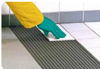
2. Bevor eine Hautbildung einsetzt (aufgekämmten Klebemörtel mit dem Finger auf Klebrigkeit überprüfen) sind die Fliesen in das frische Mörtelbett einzuschieben und anzudrücken.
