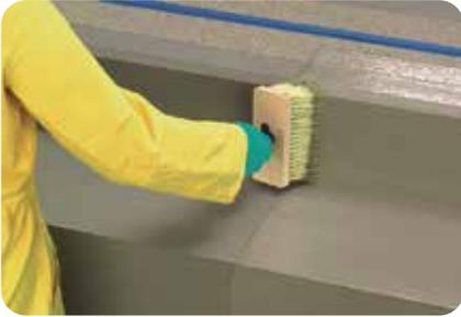
4. Der 1. Auftrag von der flexiblen Dichtungsschlämme **weber.xerm 844** sollte mit einer festen Bürste oder einem Quast erfolgen. Nur so ist sichergestellt, dass kleinste Poren oder Lunkerstellen gefüllt und geschlossen werden.
