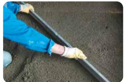
**1.** **weber.xerm 869** wird in einer Mindestdicke von 5 cm aufgebracht, plan abgezogen und leicht angeklopft.
