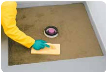
**4.** Bevor der Estrich eingebracht wird, wird der Randdämmstreifen zu angrenzenden Bauteilen/Wänden gestellt. Beim anschließenden Einbringen des Estrichs ist zu beachten, dass bei Ausgleichsdicken über 43 mm keine Haftbrücke erforderlich ist (Herstellung eines selbsttragenden Estrichs).
