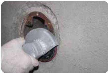
3. Die Abdichtung wird bis auf die gereinigten und angeschliffenen Flansche von Einbauten gezogen.
