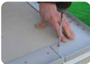
3. Zunächst werden die entsprechenden Randprofile (Watec Drain DP 21, Fa. Gutjahr) auf dem Untergrund fixiert und anschließend verdübelt und kraftschlüssig verschraubt \*).
