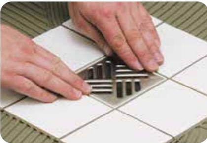
**10.** Nach Durchtrocknung der Abdichtung (witterungsabhängig nach 4 Stunden) werden die Fliesen mit **weber.xerm 853 F** verlegt. Das Einsetzelement für den Rost ist drehbar und verschiebbar sowie in der Höhe einzustellen. Damit kann der Rost dem Fugenschnitt und der Plattenhöhe entsprechend eingesetzt werden.
