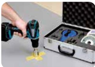
**1.** Zum Bohren oder Schneiden von Installationsöffnungen usw. ist die Verwendung von speziellen Diamantbohrkronen und Trennscheiben in den entsprechenden Größen als echte Erleichterung dringend zu empfehlen. Ggf. sollten vorher entsprechende Schablonen aus Pappe o.ä. vorgefertigt werden.
