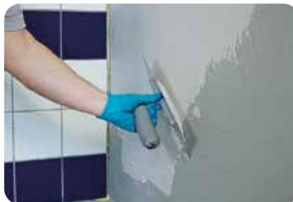
1. Nach Durchtrocknung der Abdichtung wird eine Kontaktschicht mit z.B. **weber.xerm 861** aufgespachtelt. Sofort danach wird mit einem Kammspachtel in einem Winkel von 45–60 ° ein gleichmäßiges Klebebett aufgezo-
