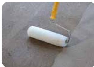
4. Der Untergrund wird mit **weber.prim 801** grundiert. Als schnelle Multifunktionsgrundierung kann auch **weber.prim 804** eingesetzt werden.
