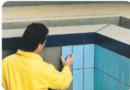
2. Um eine hohlraumfreie Fliesenverlegung zu gewährleisten, ist bei der Verlegung das „Kombinierte Verfahren“ (buttering-floating) zu wählen. Eine 95%-ige Bettung ist hierbei anzustreben. Die Fliesen sind, bevor eine Hautbildung einsetzt, in das frische Mörtelbett einzuschieben und anzudrücken.
