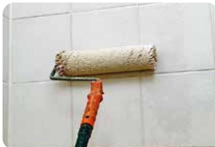
**2.** Tragfähige alte Fliesenbeläge werden zunächst mit **weber.prim 803** grundiert.
