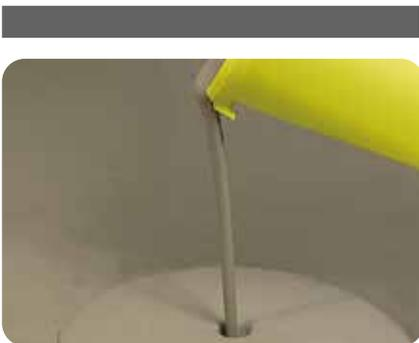
2. Die Nivelliermasse wird, beginnend am tiefsten Punkt des Untergrundes, ausgegossen.
