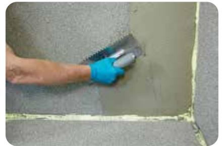
1. Der Untergrund wird mit **weber.xerm 848** Reaktionsharzkleber und Fugenmörtel abgespachtelt und egalisiert, um später einen gleichmäßigen Klebeauftrag zu bekommen.
