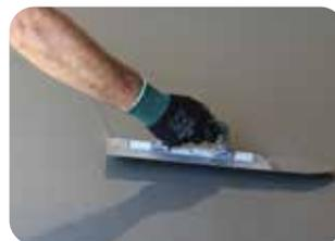
**3.** Anschließend wird die Nivelliermasse mit einer Glättkelle, dem Rakel oder einer Stachelwalze in der benötigten Schichtdicke (mind. 10 mm dick) gleichmäßig verteilt. Der Einsatz einer Stachelwalze bewirkt ein optimales Entlüften zur Verhinderung von Lufteinströmen in der ausgehärteten Spachtelmasse.
