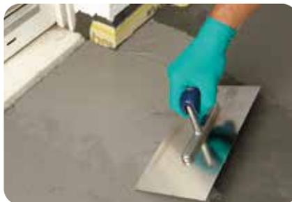
2. Im Anschluss wird **weber.xerm 844** in Form einer Kratzspachtelung aufgetragen.
