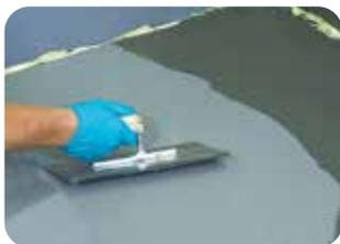
3. Anschließend erfolgt ein zweimaliger Flächenauftrag aus **weber.xerm 844**.
