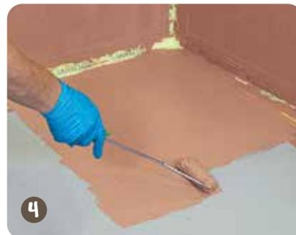
Anschließend wird der erste Flächenauftrag mit **weber.tec 822** aufgebracht. Das Material lässt sich mit dem Glätter, Pinsel oder einer Lammfellrolle auftragen.
