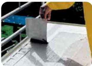
2. Die Randprofile werden ebenfalls mit der Dichtungsschlämme und dem Dichtband überarbeitet (Randprofile mit **weber.xerm 844** vollflächig einstreichen, Dichtband eindrücken und verkleben).
