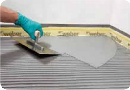
4. Der 2. Auftrag der flexiblen Dichtungsschlämme kann mit einer Glättkelle satt und gleichmäßig aufgetragen werden. Die Mindesttrockenschichtdicke der Abdichtungsschicht muss mind. 2,0 mm betragen.
