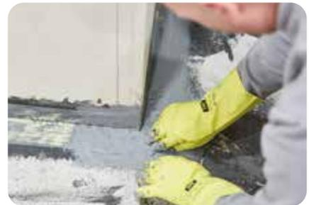
**3.** Im Eck-, Dehn-, Stoß- und Bewegungsfugenbereich werden die Dichtbandkomponenten **weber.tec 828 DB** zunächst in die frisch vorgelegte Dichtungsschrämme aus **weber.xerm 844** eingebettet.
