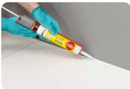
2. Anschluss- und Bewegungsfugen sind mit **weber.fug 880** oder **weber.fug 881** elastisch zu verfugen. Bei Natursteinbelägen ist **weber.fug 883** einzusetzen. Zur Haftverbesserung ist, je nach Saugfähigkeit, **weber.fug 884/885** zu verwenden.
