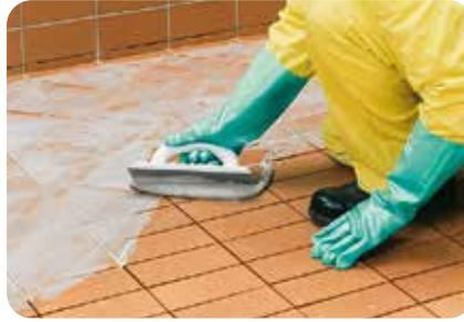
1. Nach Aushärten des Fliesenklebers kann der fertige Belag mit dem Reaktionsharzfügmörtel **weber.xerm 848** verfugt werden.
