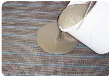
2. Nach Aushärtung des Klebers können die Heizmatten und angrenzenden Bodenflächen mit einer selbstverlaufenden Bodenspachtelmasse, z.B. **weber.plan 813-25**, ausgeglichen werden.
