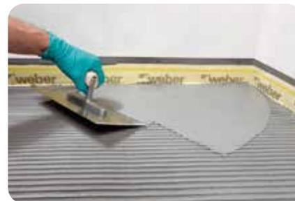
1. Laut Bauregelliste ist es erforderlich, die Abdichtung im Verbund (AiV) zwei Mal aufzutragen. Hierbei ist eine Gesamttrockenschichtdicke von mind. 2 mm zu erzielen.
