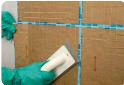
3. Danach wird das Mosaik ausgerichtet und mit dem Epoxi-Fugbrett in den Kleber eingedrückt. Speziell im Nass- und Dauernassbereich ist es wichtig, dass das Mosaik vollflächig eingebettet wird.
