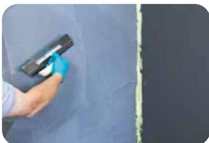
8. Abschließend kann die Flächenabdichtung (je nach Wassereinwirkungsklasse) erstellt werden und die Wannenranddichtbänder können in die Flächenabdichtung mit eingebunden werden.
