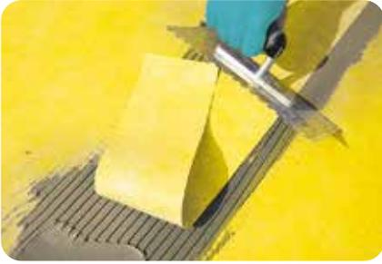
4. Die Stoßbereiche werden mit dem Dichtband **weber.tec 828 DB** abgedichtet. Hierzu wird nochmals mit dem Kammspachtel, auf Breite des Dichtbandes, **weber.xerm 844** oder **weber.xerm 860 F** aufgezogen.
