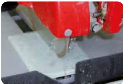
6. Ausschnitte sind mit elektrischen Schneidmaschinen mit Wasserkühlung durchzuführen.)\*
