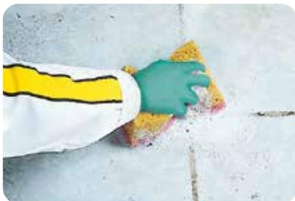
1. Haftungsmindernde Verunreinigungen auf der Oberfläche des alten Fliesenbelages sind sorgfältig zu entfernen. Fettige und ölige Bestandteile sind mit einem fettlösendem Reiniger zu entfernen.
