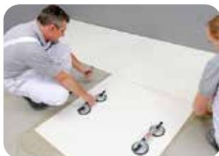
1. Mit einem entsprechenden Draht muss die Benetzung zwischen Fliese und Klebebett durchtrennt werden. Erst dann kann die bereits verlegte Fliese aus dem frischen Klebebett aufgenommen werden.
