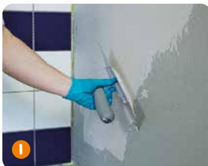
Nach Durchtrocknung der Abdichtung wird eine Kontaktschicht mit z. B. **weber.xerm 861** aufgespachtelt. Sofort danach wird mit einem Kammspachtel in einem Winkel von 45-60 ° ein gleichmäßiges Klebbett aufgezogen.
