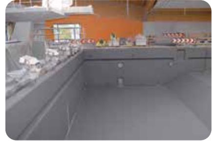
6. Nach Trocknung der Abdichtungsschicht ist zur Überprüfung der Wasserundurchlässigkeit eine 14-tägige Probefüllung des Beckens mit gechlortem Wasser durchzuführen.
