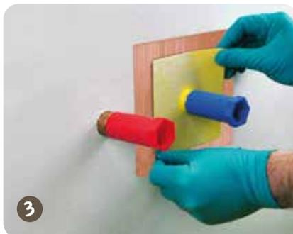
Zur Abdichtung an Sanitäranschlüssen müssen die speziellen Manschetten **weber.tec 828 MDK** eingesetzt werden.
