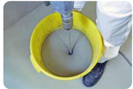
1. Die selbstverlaufende Bodenausgleichsmasse, z.B. **weber.plan 813-25**, wird mit einem geeigneten Rührwerk gemäß den Verarbeitungshinweisen angerührt.
