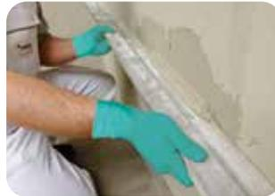
**3.** Im Wandbereich können kleinflächige Unebenheiten mit entsprechendem Klebemörtel, wie z.B. **weber.xerm 861**, ausgeglichen werden. Für größere Ausgleichsarbeiten empfiehlt es sich, den **weber.plan 818** zu verwenden.
