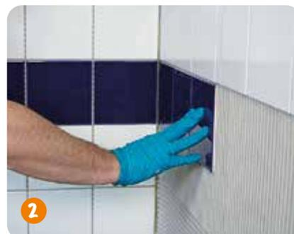
Bevor eine Hautbildung einsetzt (aufgekämmten Klebemörtel mit dem Finger auf Klebrigkeit überprüfen), die Fliesen in das frische Mörtelbett einschieben und andrücken.
