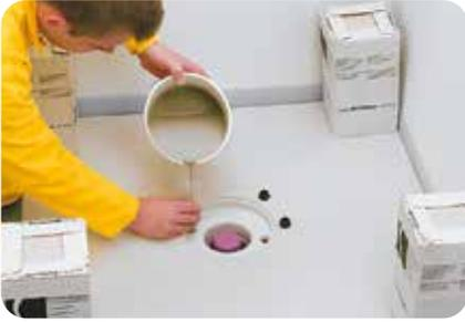
**7.** Zur Lagesicherung wird das Element an den Ecken belastet (ohne die Höhenlage zu ändern). Vorhandene Hohlräume im Bereich des Bodenablaufes bzw. des Deckendurchbruchs bei senkrechtem Ablauf werden durch die vorhandenen Öffnungen mit **weber.rep 767** vollständig vergossen. Der Deckendurchbruch wird vorab von der unteren Etage aus gedämmt. Die Vergussöffnungen sind mit dem Gummistöpsel zu verschließen.
