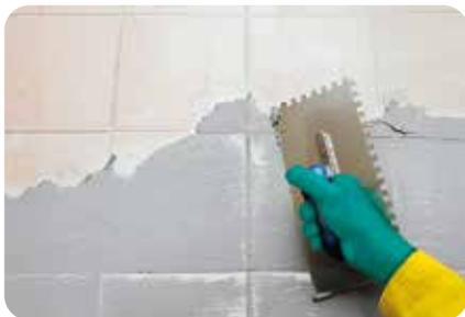
2. Nach Trocknung der Grundierung wird eine Kontaktschicht z.B. mit **weber.xerm 861** aufgespachtelt. Sofort danach wird mit einem Kammspachtel in einem Winkel von 45–60° ein gleichmäßiges Klebebett aufgezogen.
