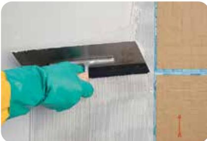
2. Nach gleichmäßigem Klebeauftrag wird überschüssiges Material mit der Spitzzahngleiste Nr. 1 abgekämmt, damit kein Kleber beim Einlegen des Mosaiks aus den Fugen ausquillt.
