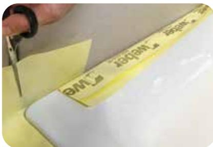
1. **weber.tec 828 ME SK** am Rand der Duschwanne verkleben und mit einem druckfesten Gegenstand andrücken. Die Ecke kann an den vorperforierten Stellen geklappt oder eingeschnitten werden. Entsprechenden Abstand zur Flächenbündigkeit beachten.
