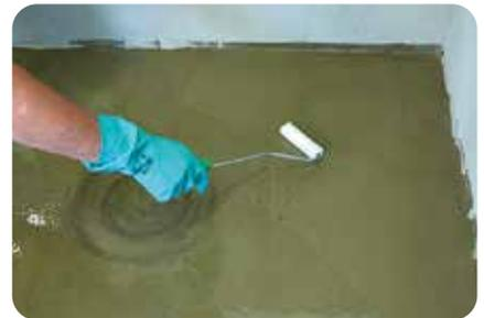
1. Die Gesamtfläche, einschließlich des Rinnenbereichs, wird mit der lösemittelfreien Epoxi-Grundierung **weber.prim 807** grundiert.
