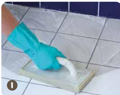
Nach Aushärten des Fliesenklebers kann der gesamte fertige Belag (Wand und Boden) mit dem wasser- und schmutzabweisenden Longlife-Premium Fugenmörtel **weber.fug 875 BlueComfort** verfugt werden. Dieser Fugenmörtel zeichnet sich durch eine hohe Sanitärreineigerbeständigkeit aus.
