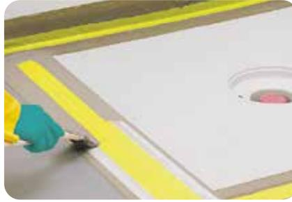
**8.** Die Fuge zwischen Estrich und Element wird mit **weber.xerm 853 F** kraftschlüssig gefüllt. Ist mit Bewegungen zwischen dem Duschwannenelement und dem Estrich zu rechnen, ist eine Bewegungsfuge anzuordnen. Anschlussfugen sind mit **weber.xerm 844** und dem entsprechenden Dichtbandsystem **weber.tec 828** abzudichten.
