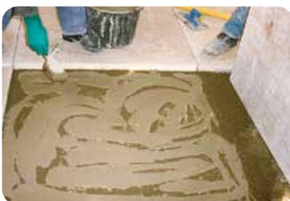
3. Zur Verlegung der Fliesen- oder Natursteinplatten auf den erdfuchten Dickbettmörtel wird die Haftbrücke nochmals auf der Plattenrückseite oder dem Dickbettmörtel in schlammfächtiger Konsistenz vollflächig aufgetragen.
