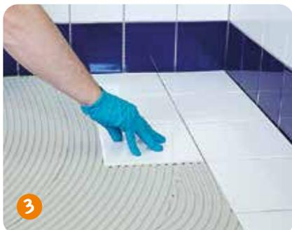
Nach Durchtrocknung der Verbundabdichtung kann der Flexklebemörtel, Universal **weber.xerm 861** auch im Bodenbereich aufgezogen werden. Auch hierbei werden die Fliesen in das frische Mörtelbett eingeschoben und eingedrückt. Die Fugen vor Erhärten des Mörtels auskratzen.
