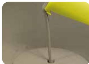
**2.** Die Fließspachtelmasse wird, beginnend am tiefsten Punkt des Untergrundes, ausgegossen.
