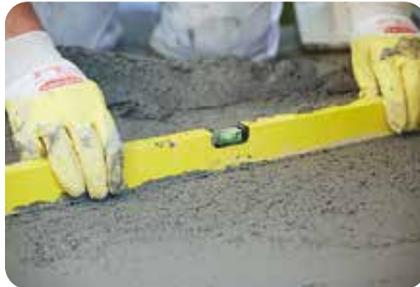
2. Ausgleichsschichten werden mit **weber.plan 819** ausgeführt.
