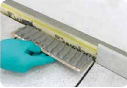
1. Die Verlegung von keramischen Wandbekleidungen ist ebenfalls mit **weber.xerm 844** ohne weiteres möglich. Zur weiteren Erhöhung der Standfestigkeit bei Verlegen von größeren und schwereren Fliesen und Platten, kann die Konsistenz von **weber.xerm 844** durch Zugabe von **weber.sys Hartquarzmaterial** im MV von max. 1:1 optimiert werden.
