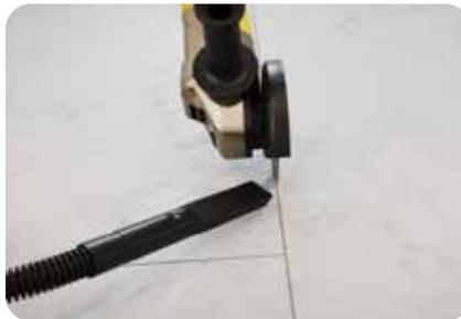
2. Lokalisierte Stellen sollten im Fugenbereich geöffnet werden. Dies kann durch Einschneiden oder durch Anbohren der Fugen erfolgen. Hierbei ist zu beachten, dass der dabei gebildete Staub mittels Industriestaubsauger sorgfältig entfernt wird.
