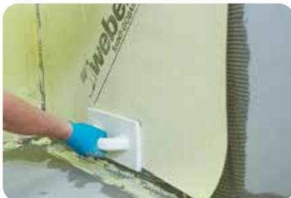
1. Die zuvor zugeschnittenen Bahnen aus **weber.tec 825** werden zunächst im Wandbereich ins frische Kleberbett eingelegt und mit einem geeigneten Werkzeug blasenfrei angedrückt und geglättet.
