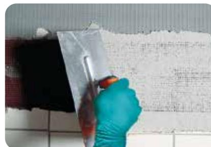
4. Die Übergänge von der Ausgleichsschicht zum alten Fliesenbelag werden mit einer Gewebespachtelung aus z.B. weber.xerm 861 und weber.sys 835 versehen.
