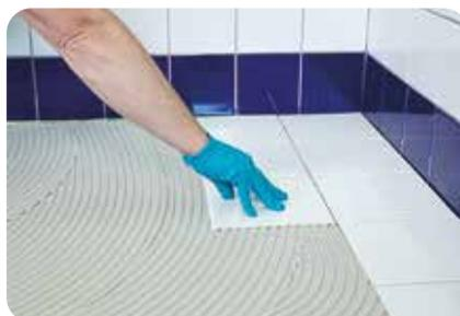
3. Bevor eine Hautbildung einsetzt (aufgekämmten Klebemörtel mit dem Finger auf Klebrigkeit überprüfen), sind die Fliesen in das frische Mörtelbett einzuschieben und anzudrücken. Die Fugen sind vor Erhärten des Mörtels auszukratzen.
