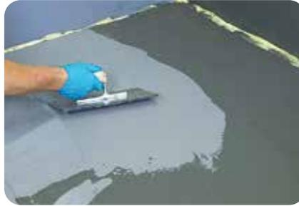
5. Der 2. Auftrag der flexiblen Dichtungsschlämme kann mit einer Glättkelle satt und gleichmäßig aufgetragen werden. Die Mindesttrockenschichtdicke der Abdichtungsschicht muss mind. 2,0 mm betragen.
