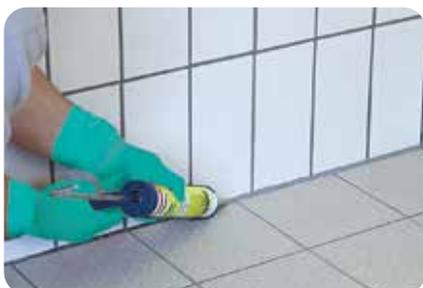
3. Anschluss- und Bewegungsfugen können auch in Lebensmittelbereichen mit **weber.fug 880** ausgebildet werden. Zur Haftverbesserung ist, je nach Saugfähigkeit **weber.fug 884/885** zu verwenden.
