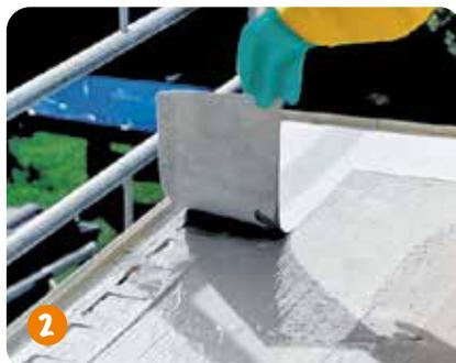
2 Wenn zuvor ein Fliesen-Abschlussprofil eingebaut wurde, wird auch dieses mit dem Dichtband entsprechend überarbeitet.
