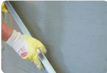
2. Ausgleichsschichten werden mit **weber.plan 819** ausgeführt.
