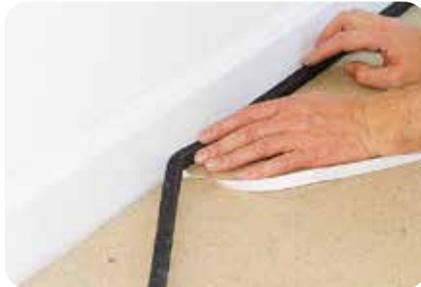
2. Zur Vermeidung von Schallbrücken sollte zu angrenzenden Bauteilen (z.B. Wände, Rohrdurchführungen usw.) ein Randdämmstreifen eingebaut werden.
