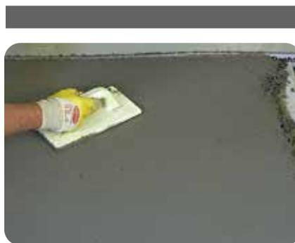
4. Hiernach wird die Oberfläche mittels eines Reibe Bretts abgerieben, sodass eine einheitliche geschlossene Oberfläche entsteht.
