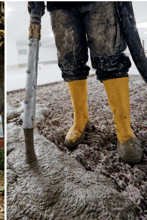
Bei der Sanierung von Industrieböden muss häufig zunächst der **Betonuntergrund fachgerecht instand gesetzt werden** – je nach Objekt mit oder ohne statische Anforderungen.
