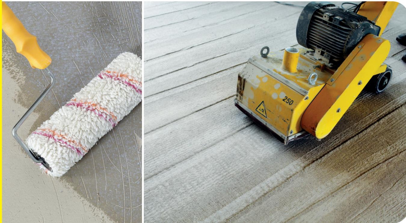
Ist der Untergrund nicht **sorgfältig** vorbereitet, **nutzt das beste Bodensystem nichts – die Beschichtung kann keinen Verbund zum Untergrund eingehen und löst sich bereits bei geringen Belastungen wieder ab.**
