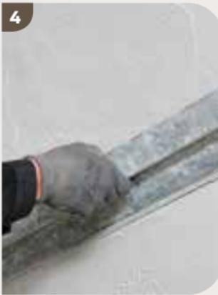
3./4. Den Sanierputz vollflächig 10–20 mm dick auftragen. Den frisch aufgetragenen Putzmörtel lattenrecht und nestfrei abziehen. Anschließend horizontal auskämmen.
