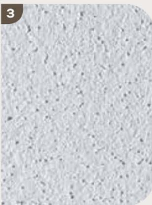
2. Aufgetragenes Material je nach gewünschter Struktur mit einer Filzscheibe, Schwamm- oder Filzbrett filzen.
