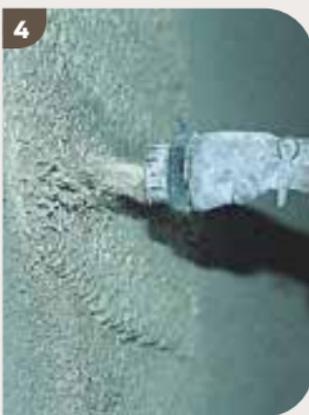
3. Fehlstellen werden kraftschlüssig im Mauerverband ausgebessert.
