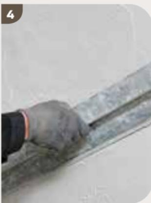
3./4. Den Sanierputz vollflächig 20–30 mm dick auftragen. Den frisch aufgetragenen Putzmörtel lattenrecht und nestfrei abziehen.
