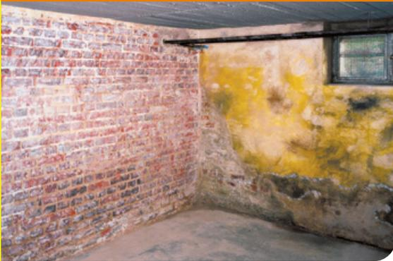
Der Untergrund ist von haftungsmindernden Bestandteilen zu befreien. Schadhafte Putze, lose und abblätternde Mörtel- und Belagsreste, sowie Farbanstriche sind bis mind. 80 cm oberhalb der schadhafte Zone sorgfältig zu entfernen. Es muss ein für die Folgearbeiten ausreichend ebener und tragfähiger Untergrund vorhanden sein. Gipsputze sind restlos zu entfernen und mürbe Fugen müssen mind. 2 cm ausgeräumt werden.
