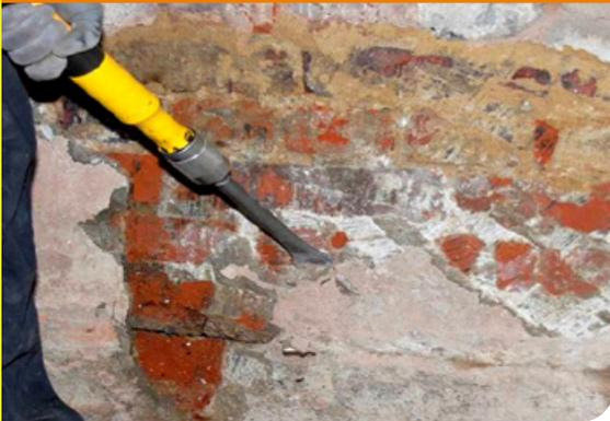
Ein Rückbau muss grundsätzlich bei folgenden durchzunässten Untergründen erfolgen: Tapeten, Gipsputz/-bauplatten/-karton, Lehmputz, Kalkputze, Dämmstoffe, Baustoffe in Plattenform, z.B. Holzbaustoffe, wie Spanplatten, Weichfaserplatten oder sonstige feuchteempfindliche Baumaterialien.
