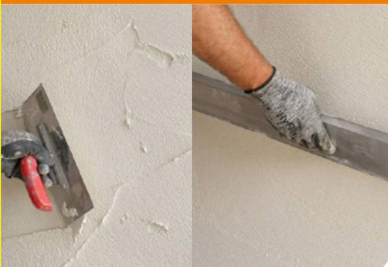
Bei der Sanierung sind feuchteunempfindliche Putze zu verwenden. Wir empfehlen z.B. den Sanierputz **weber.san 958**. Vorgehensweise: Vollflächige Kratzspachtelung aus **weber.san 958** als Haftbrücke aufbringen. Frisch in frisch **weber.san 958** in einer gleichmäßigen Schichtdicke von mind. 20 mm aufbringen. Anschließend glätten, abreiben und nachbehandeln.
