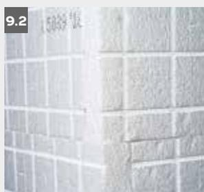
Um das Risiko von Rissen zu minimieren, sollten die Platten (mit Ausnahme der Lamelle) an Fenster- und Türecke ausgeklinkt werden, d.h. in den Ecken dürfen keine Dämmstoffugen vorhanden sein (**Abb. 10**).
