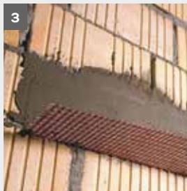
auf der Wand befestigt, in den später die Dämmplatten geklebt werden (**Abb.3**). Von vorne kommt wiederum ein Panzereckwinkel auf die Dämmplatten, so dass die unteren Platten U-förmig von Panzereckwinkeln umfasst werden.
