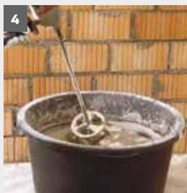
Die Platten müssen vor Feuchtigkeit geschützt gelagert werden. Durchnässte oder schadhafte Platten dürfen nicht eingebaut werden. Die Verklebung erfolgt mit den Klebe- und Armierungsmörteln **weber.therm 300/301**. Bei nicht saugenden Untergründen z.B. dichtem Beton oder Klinker sollte der Klebemörtel speziell **weber.therm 370** verwendet
