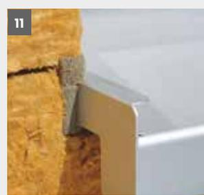
Die Plattenstöße sind zur Vermeidung von Wärmebrücken mörtelfrei zu halten. Auch bei exakter Arbeitsweise sind Fehlstellen und Fugen nicht immer zu vermeiden, die aber mit dem gleichen Dämmstoff verschlossen werden müssen (**Abb. 12**).
