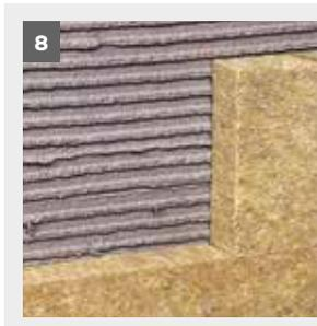
Der Abstand der Mörtelwülste darf 10 cm nicht übersteigen und es müssen mind. 50 % des Untergrundes mit Kleber bedeckt sein. Alternativ kann der Klebemörtel auch vollflächig aufgespritzt und mit Zahnglätter (10 x 10 mm) aufgekämmt werden. Die Dämmplatten werden sofort danach (max. 10 Minuten nachdem Anspritzen des Klebemörtels, je nach Witterung und Untergrund auch weniger) in den Mörtel
