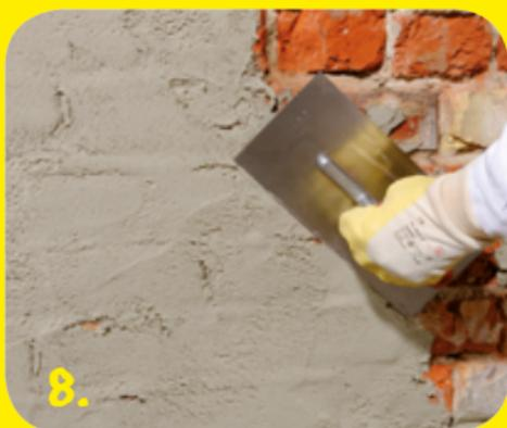
Mauerwerksfugennetz mit **weber.tec 933** verschließen.
