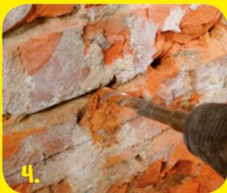
Löcher ( $\varnothing$  16 mm) horizontal in die Lagerfuge bohren.
