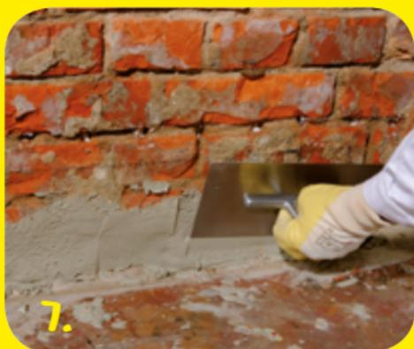
Ausgestemte Nut am Fußpunkt mit Haftbrücke aus **weber.tec 933** (schlammfähig eingestellt) vorschlämmen. Kehlnut mit **weber.tec 933** ausspachteln.
