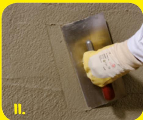
Wassersperrputz **weber.tec 934** in ca. 20 mm Dicke aufbringen. Putzflächen egalisieren, später filzen.
