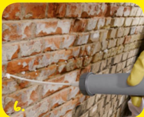
Bohrlöcher von hinten nach vorne mittels Handdruckspritze vollständig mit Injektionscreme füllen.
