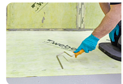
14. weber.tec 825 Dichtbahn in die frische Klebeschicht einbetten. Installationsöffnungen entsprechend einschneiden und sorgfältig überarbeiten.
