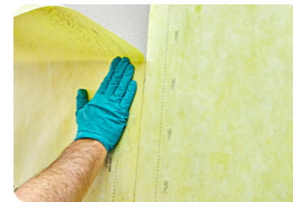
10. Im Anschlussbereich weber.tec 825 auf Stoß verkleben und fest andrücken.
