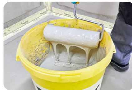
6. weber.tec 824 zu einer gut rollbaren Konsistenz anmischen. Hierzu maximal 6 Liter Wasser dem Sackinhalt hinzugeben.
