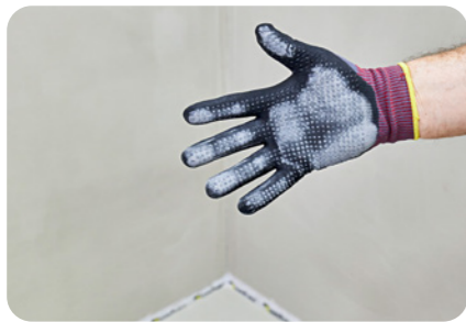
1. Untergrund auf Tragfähigkeit überprüfen. Staub oder lose Bestandteile sind zu entfernen.
