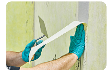
12. Das Dichtband weber.tec 828 anschließend möglichst flächenbündig in die frische Kleberschicht einarbeiten.
