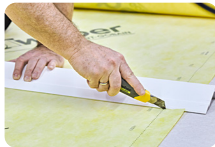
5. Die Dichtfolie weber.tec 825 auf das richtige Maß zuschneiden.
