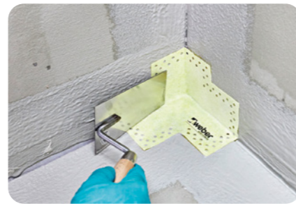
3. weber.tec 824 vorlegen und zunächst die weber.tec 828 Innenecke in den frischen Kleber einbetten.
