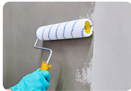
2. Mit weber.prim 801 werden saugende Untergründe vorbehandelt, nicht saugende mit weber.prim 803.
