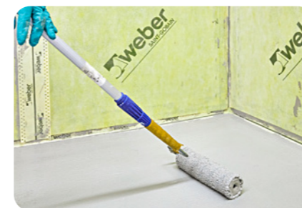
13. Auch auf Bodenflächen erfolgt der Auftrag des Rollklebers mit einer Lammfellrolle.
