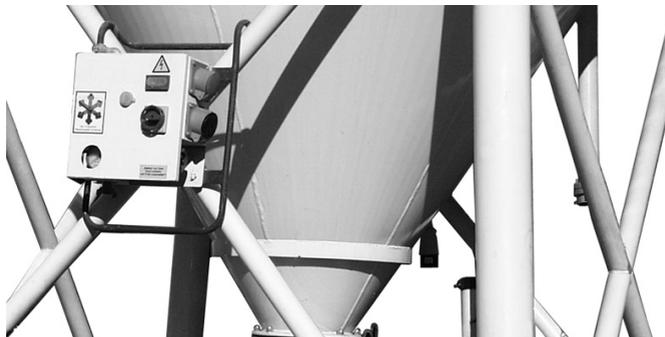
*Abb. 13: Schaltschrank am Silokreuz*
