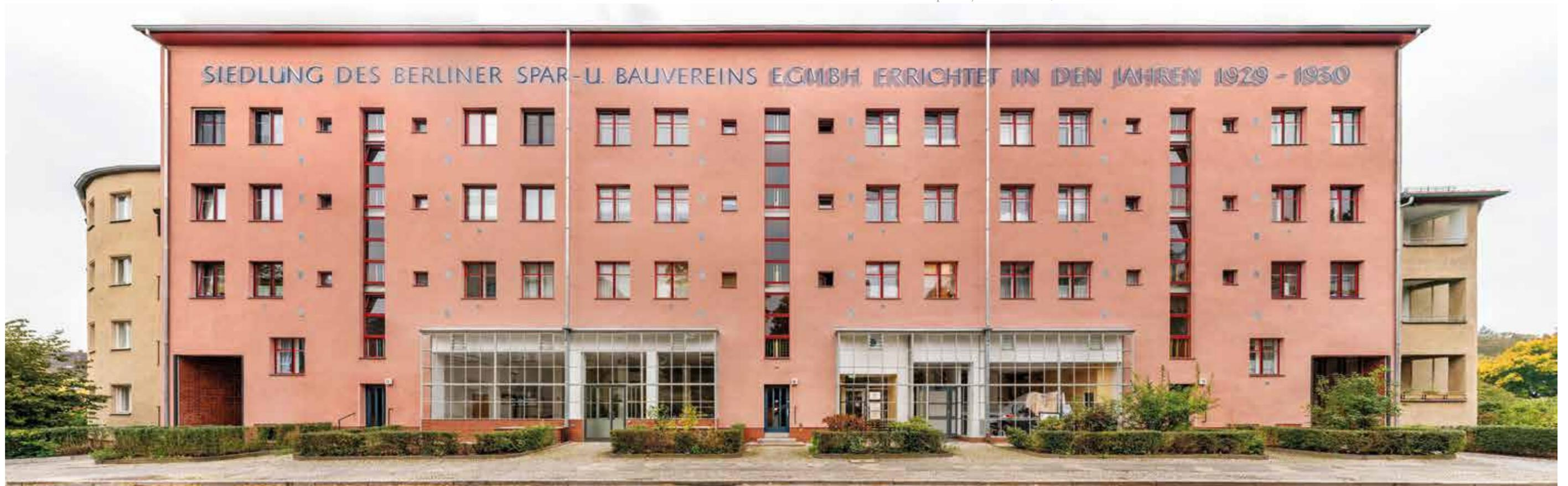
Im Jahr 2009 wurden die Putzfassaden des Hufeisens entsprechend der Planung vom Berliner Büro Winfried Brenne Architekten und den Vorgaben des Landesdenkmalamtes saniert. Hierfür kam eine Sonderrezeptur von Saint-Gobain Weber zum Einsatz: Der auf Basis eines Münchner Rauputzes entwickelte Putz enthält Zuschläge von Quarzsand und Rollkies, um sich dem historischen Original so weit als möglich anzugleichen.
