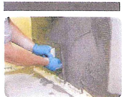
2. Mit einem 4 mm Zahnglätter wird weber.xerm 859 F auf den abzudichtenden Untergrund aufgekämmt.
