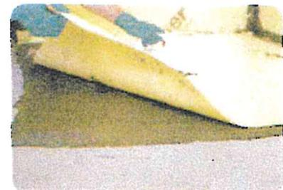
3. Die ebenfalls zuvor zugeschnittenen Bahnen aus weber.tec 825 werden nach dem gleichen Prinzip wie im Wandbereich mit einem geeigneten Werkzeug blasenfrei angedrückt und geglättet.
