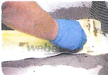
1. Nach vollständiger Trocknung der Grundierung wird in allen Anschlussbereichen das elastische Dichtband weber.tec 828 DBG eingebaut. Dazu werden die zur Verwendung kommenden Dichtkomponenten in das Mörtelbett aus weber.xerm 859 F eingebettet und mit Spachtel oder Glätter angedrückt.
