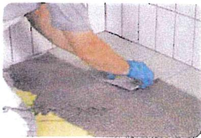
3. Nach der Verlegung der Wandfliesen erfolgt die Bodenverlegung, ebenfalls mit weber.xerm 859 F oder mit weber.xerm 844. Es ist darauf zu achten das eine ausreichend große Zahnung verwendet wird, um ein möglichst vollsattes Mörtelbett zur gewährleisten.
