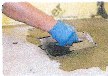
2. Im Anschluss wird auch im Bodenbereich mit einem 4 mm Zahnglätter der weber.xerm 859 F auf den abzudichtenden Untergrund aufgekämmt.
