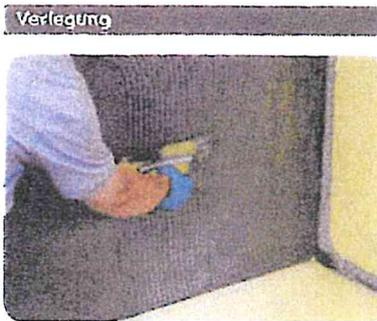
1. Zur Belagsverlegung wird zunächst eine Kontaktschicht aus weber.xerm 859 F vorgelegt. Sofort danach wird mit einem Kammspachtel in einem Winkel von 45 - 60° ein gleichmäßiges Klebbett aufgezogen.
