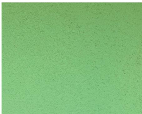
Den äußeren Abschluss bildet eine Fassade aus mineralischem Edelputz – genauer gesagt der AquaBalance-Putz weber.star 224 mit einer 2-mm-Körnung. Bild: Brandrevier
