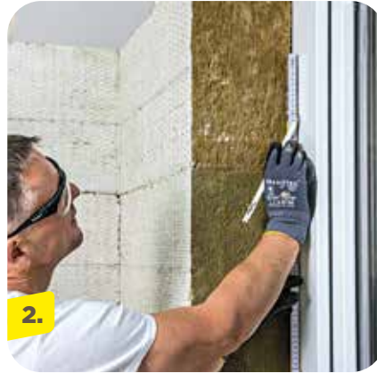
2. Leibungsbreite und -höhe an mehreren Punkten messen ...
