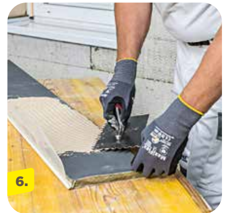
6. Leibungsplatte ebenfalls mit webertherm 302 beschichten.
