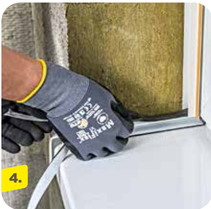
4. Fugendichtband auf das Bordprofil der Fensterbank aufkleben.
