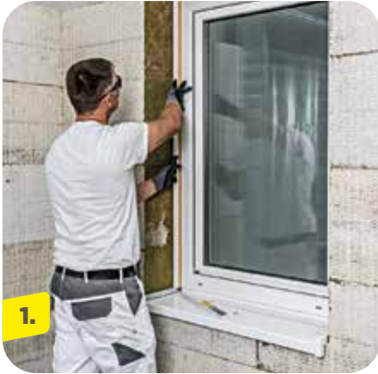
1. weber.projekt Fensteranschlussprofil auf den sauberen Fensterrahmen kleben.
