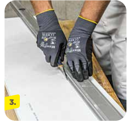
3. ... und die Leibungsplatte passend zuschneiden.
