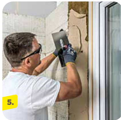
5. Klebe- und Armierungsmörtel webertherm 302 auf die Dämmplatten aufbringen.
